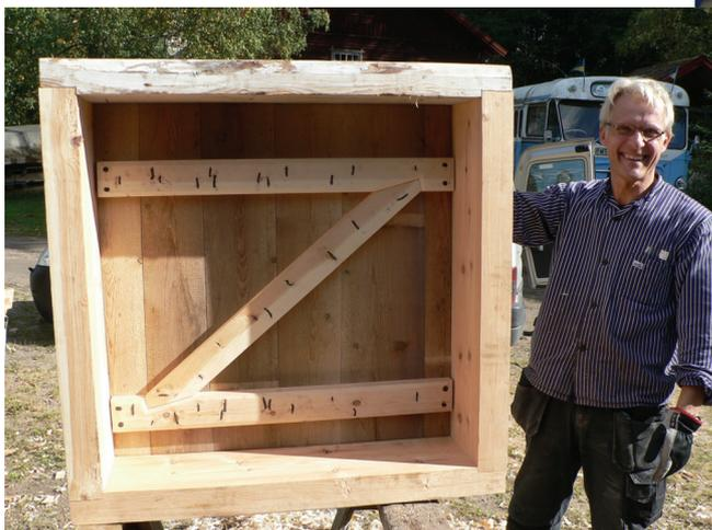
har tillverkats till ett av dörrhålet på den södra sidan av sågen. Sidostyckena tappades i det befintliga överstycket och i ett nytillverkat understycke. Utsidan, delen som ligger mot murliv och mark tjärades för att bättre stå emot fukt. En bräddörr tillverkades av spontade bräder, lik den vänstra dörren i fasaden. Vål valt
