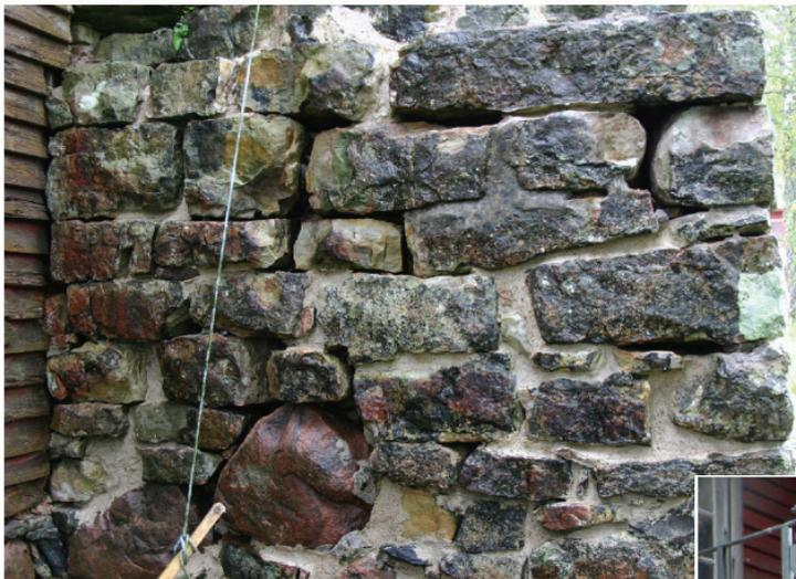
Skorstenssockeln hade skador i form av bortfallet bruk och fog, bland annat på grund av att växtlighet har slagit rot och dess rötter har sprängt sönder bruk och fog. Vatten har haft möjlighet att leta sig in i sockeln och följts av frostsprängning vintertid. Arbetet med sockeln och skorstenen påbörjades sommaren 2009 och 2010 års arbete innebär bland annat
