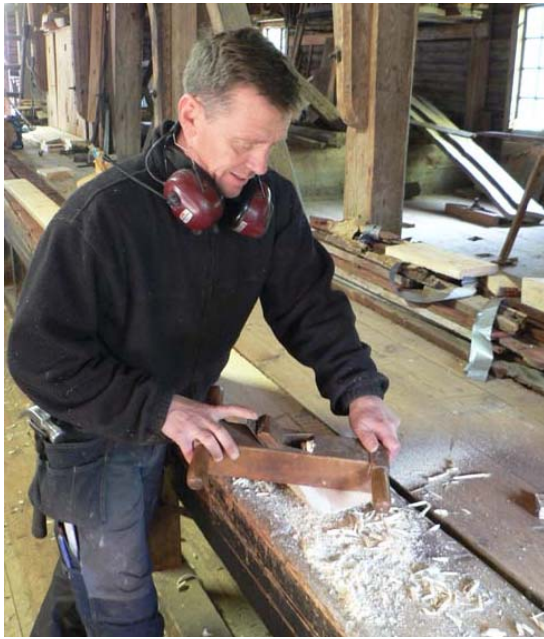
Hyvling av utvändig panel .... bild ovan Tillverkning av nya delar med hjälp av lämpliga handverktyg..... bild till höger
