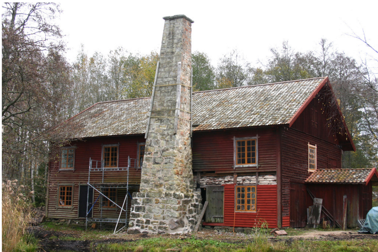
De sex fönstrens bågar, till vänster om skorstenen, är åter på plats efter renovering och målning. Den borte gavelns dubbelbåge renoverades också. Bågen är lik den som sitter i den västra gaveln och som syns på fotot.
