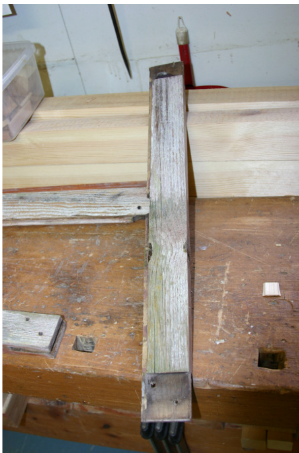
Spröjs och understycke som byts ut till motsvarande i ny tätvuxen furu.
