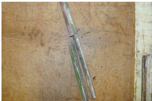
Spröjs och understycke som byts ut till motsvarande i ny tätvuxen furu.
