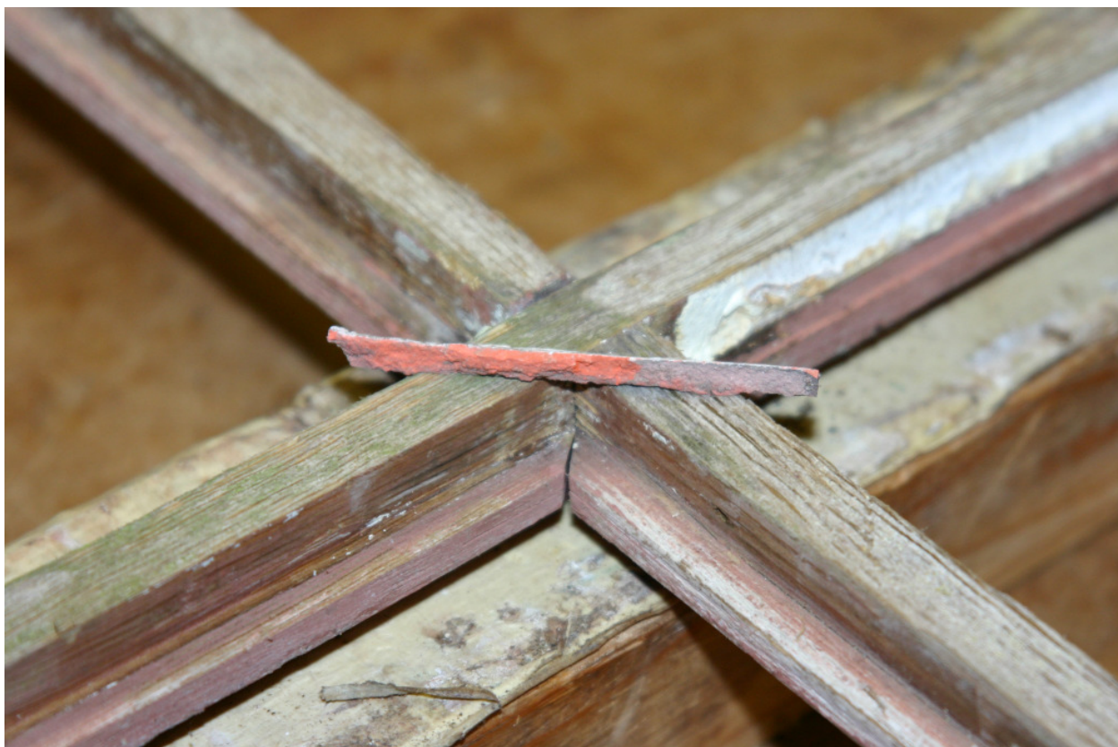
En del av kittet som togs bort var skarpt orange som bilden ovan visar. Nyansen är lik den som blymönja har vilket kan tyda på att man blandat i en liten mängd mönja i kittet. Det undersöktes dock inte.
