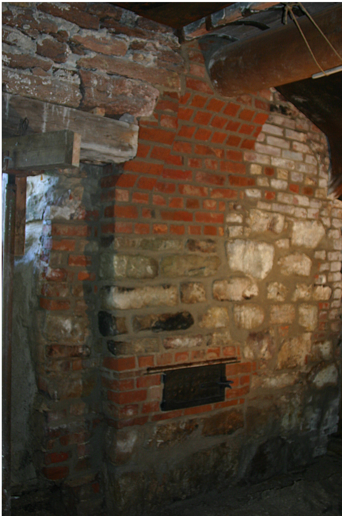
Det interiöra arbetet är klart. Fonden är uppmurad igen efter det att förstärkningarna är gjorda. Den nya smidda sotluckan är på plats och foderröret av cortenstål är monterat. Det röret och det ursprungliga röret, som kommer att återplaceras, ska att tjäna som foder för ett cortenrör, med något mindre dimension, som ska leda röken från den lokomobil, som på sikt kommer anskaffas.
