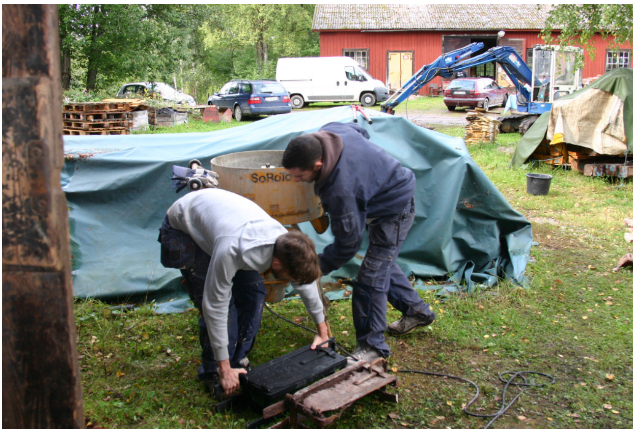
Praktikanten Jens Rundlöf visar upp den nya sotluckan liggande brevid den gamla. I sin smedja i Husaby, Götene, tillverkade smeden Therese Johansson den nya sotluckan med infästning. Den gamla användes naturligtvis som mall. Bakom Jens blandar praktikanten Sinan Unveren till bruk.
