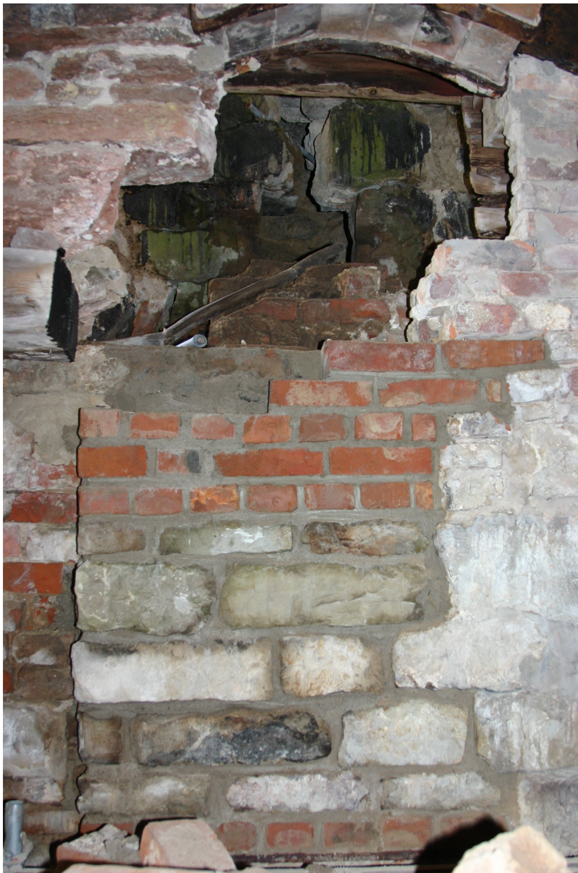
Det invändiga arbetet är klart och fronten håller på att färdigställas. Den nya sotluckan är på plats och vars överkant syns längst ned i bild. Det nya rökröret, som ska fungera som ett foderrör, ska monteras innan väggen kan göras helt klar. Rörets placering är längst upp på fotot (se också bilder på följande uppslag). Den något välvda tegelraden överst i bild är det uppvärmetåligen skyddet mot takbjälkarna.
