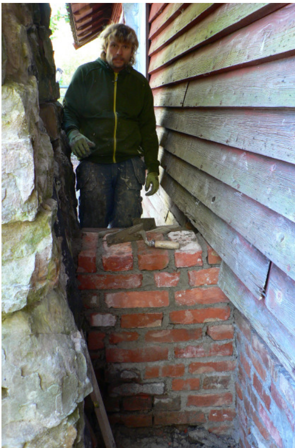
Ovan och till vänster: Kenna håller på med att klä in det nya cortenröret med tegel över delen mellan byggnaden och skorstenen. Foto Erik Bergholtz.
