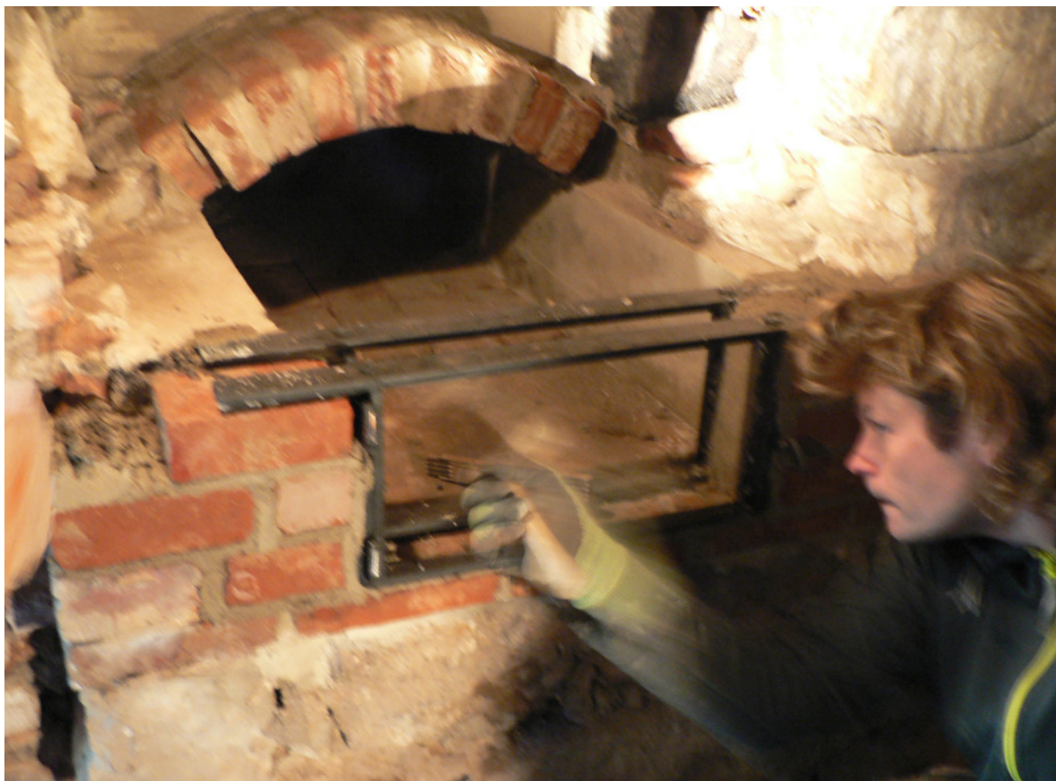
Kenna sätter sotluckan infästning på plats. Foto Erik Bergholtz.
