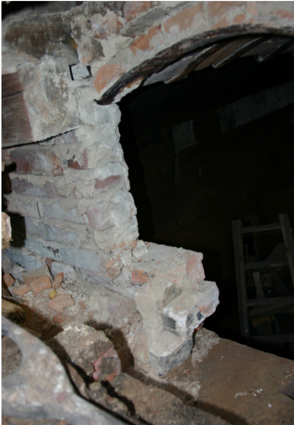
Utsidan av byggnaden där rökröret är täckt med tegel. Men innan arbetet kan fortsätta måste röret på plats.
