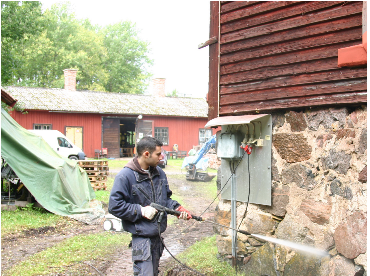
Samtidigt som arbete pågått med skorstenen har det arbetas med stensockeln. Sinan spolar rent från löst material som sand, jord, löv, gammalt bruk mm. Cementbruket från tidigare renovering knackas bort. Vid omfogningen användes kalkbruk.
