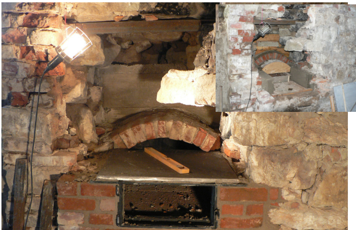
Valvet i tegel som ska föra ut trycket, ovanifrån, ned i de gjutna vedelagen som också beskrivits under tidigare bilder är klart. En gjutform byggdes för att kunna täcka den med betong (se den lilla infällda bilden Foto Erik Bergholtz) Infästningen för sotluckan och de båda gjutna plattorna är på plats. Högre upp i bild ses ett järn som sattes dit när muren plockades ner. Det togs inte bort när fronten murades upp igen utan lämnades kvar. Foto Erik Bergholtz.
