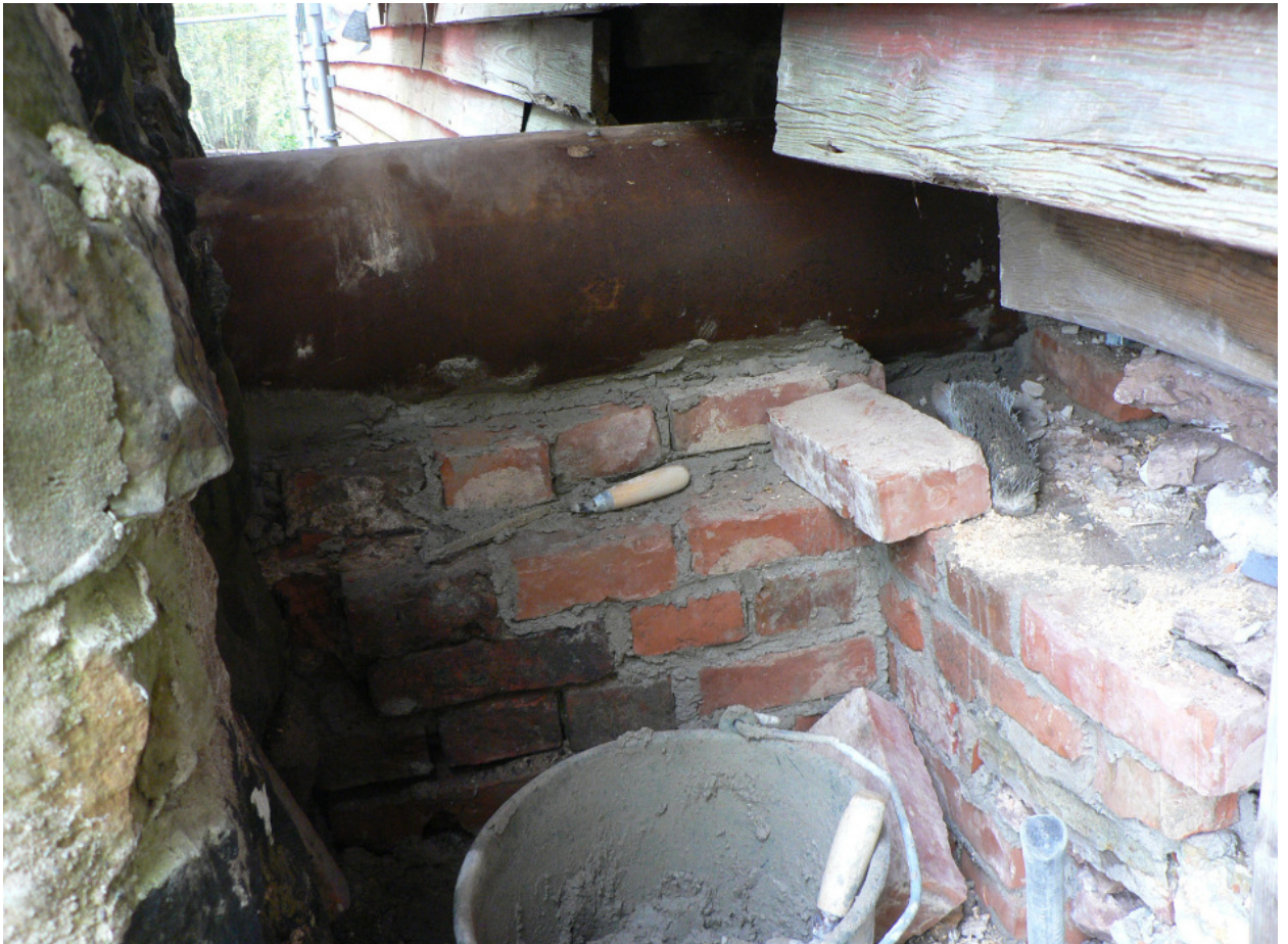
Ovan och till vänster: Kenna håller på med att klä in det nya cortenröret med tegel över delen mellan byggnaden och skorstenen. Foto Erik Bergholtz.
