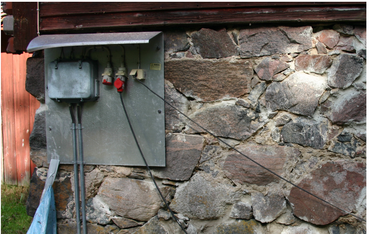
Omfogningen har påbörjats - här en del av den södra fasaden. Arbetet utförs i etapper så att bruket kan karbonatisera i de djupa fogarna.
