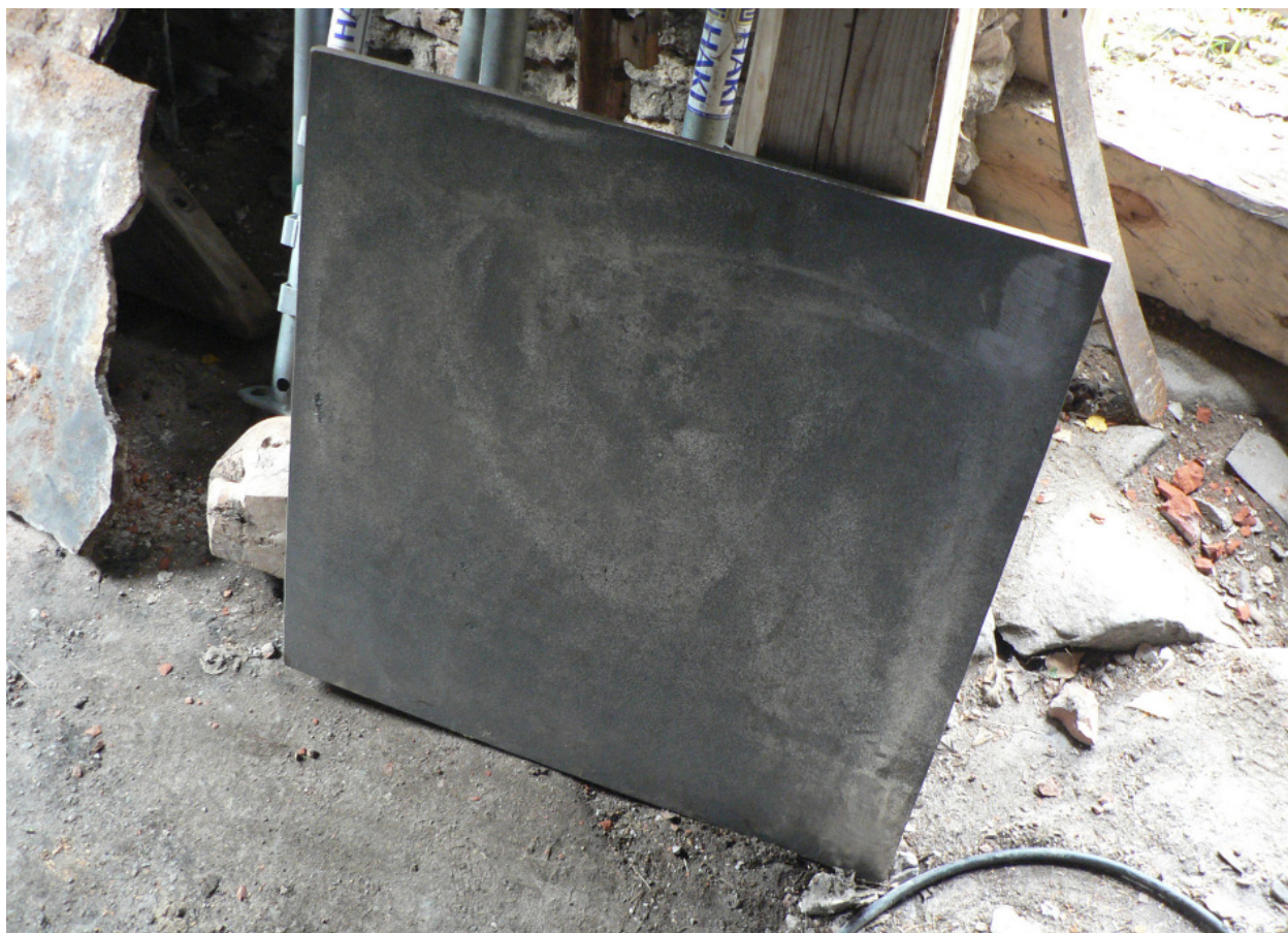
Två gjutjärnsplåtar innanför sotluckan - en i "tak" och en på "golvet" - byttes ut. En gammal plåt ses på bilden ovan och en av de nya ses nedan. Lyrestads Gjuteri AB, göt de omkring 0,6 x 0,8 m stora plåtarna. Foto nedan av Erik Bergholtz.
