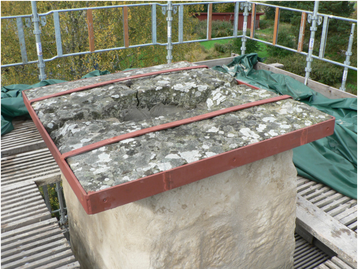
Plattjärn som har svetsats till en konstruktion som ska hålla ihop topphällen. Nedan har även blyplåten kommit på plats. Foto Erik Bergholtz.
