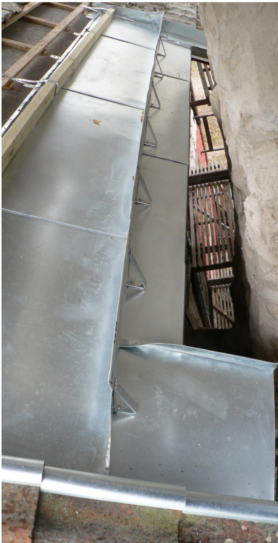
De två ovanstående bilderna visar plåtarbetet i takfoten vid skorstenen. Fotrännan ska förhindra att v regnvatten rinner ner på skorstenen och även att en snödriva blir liggande emot skorstenen, och som när den smälter, underhåller fuktigheten i murverket. Foto Erik Bergholtz.
