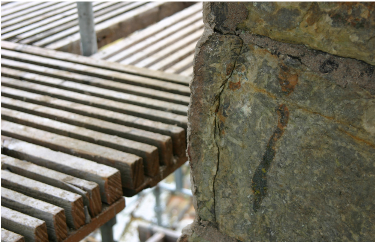
En av de små sprickor i stenen som genom slammningen tätas för intrång av vatten.
