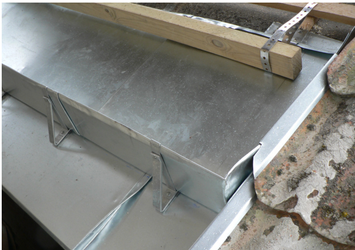
Öppningen i blyplåten har en liten uppvikt kant för att förhindra att regnavattnet rinner ned i skorstenen. Foto Erik Bergholtz
