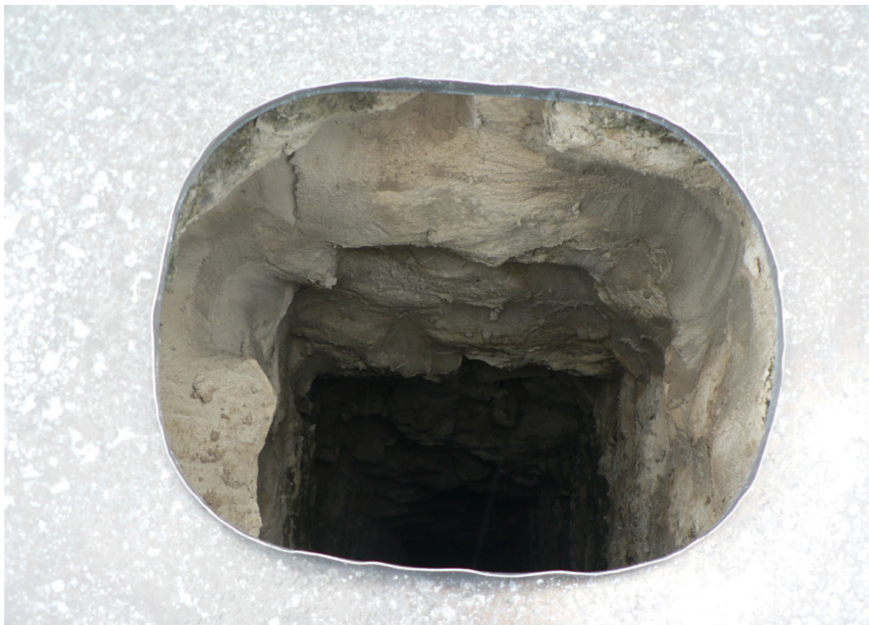
Öppningen i blyplåten har en liten uppvikt kant för att förhindra att regnavattnet rinner ned i skorstenen. Foto Erik Bergholtz
