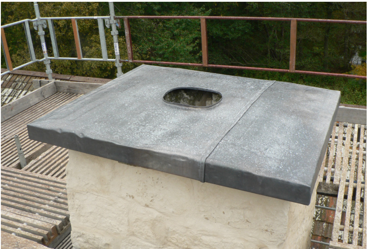
Plattjärn som har svetsats till en konstruktion som ska hålla ihop topphällen. Nedan har även blyplåten kommit på plats. Foto Erik Bergholtz.
