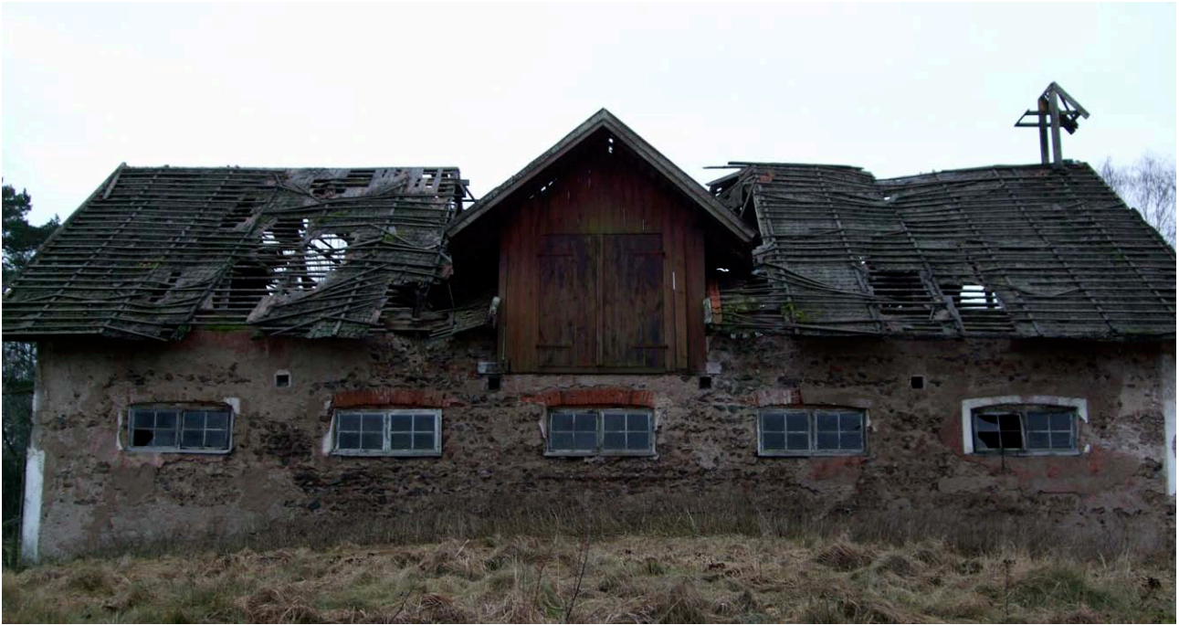
Fig. 5 Norra fasaden av stallet i Österäng
