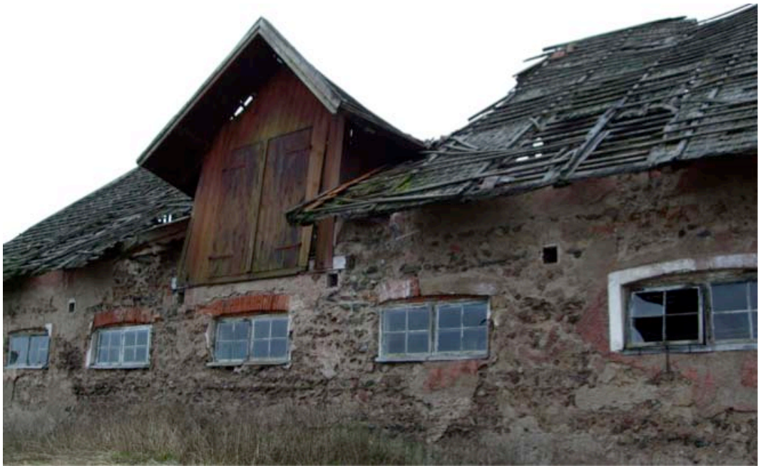
fig. 1, Stallet i Österäng. Del av fasaden mot norr med den delvis raserade lastkupan. Lastkupans underkant ligger i nivå med bjälklaget och ytterväggen reser sig ytterligare 50 cm ovanför bjälklaget. Lastkupan bryter därför igenom takfoten och är samtidigt så bred att kupan inte ryms mellan två takstolar utan "skär igenom" två mellanliggande takstolar. Det är denna typ av lastkuper med sina särskilda byggnadstekniska problem som studeras i detta arbete. Takfallen var ursprungligen täckta med en trelags spåntäckning och har senare fått ett tvåkupigt tegeltak ovanpå det. De hål som syns i bjälklagshöjd är ventilationen av stallet, något som uppmärksammades tillsammans med andra hygien- och rationalitetskrav under 1800-talets senare hälft. I ett stall avsett för 18 hästar bör det ha varit viktigt med en väl fungerande ventilation. Foto: Johannes Törnqvist
