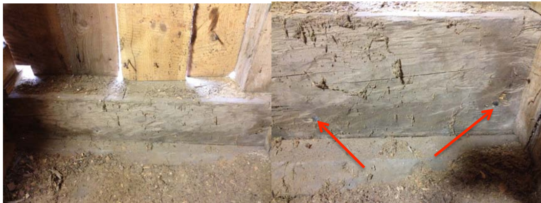
Bilder från insidan, där lusbit fastspikas i syll. Pilar visar spikplacering på syll i närbild.
