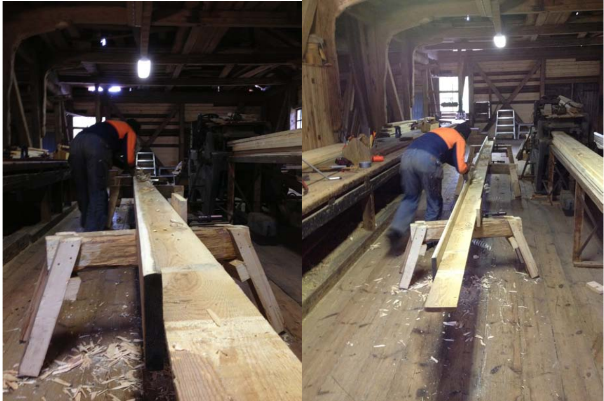
Tillverkning av de två sista förvandringspanelen på gavelsidan. Här görs fasningen som vattenbrädan ska luta emot. Fasningen görs med en rubank av Peter Eklund 2013-09-24
