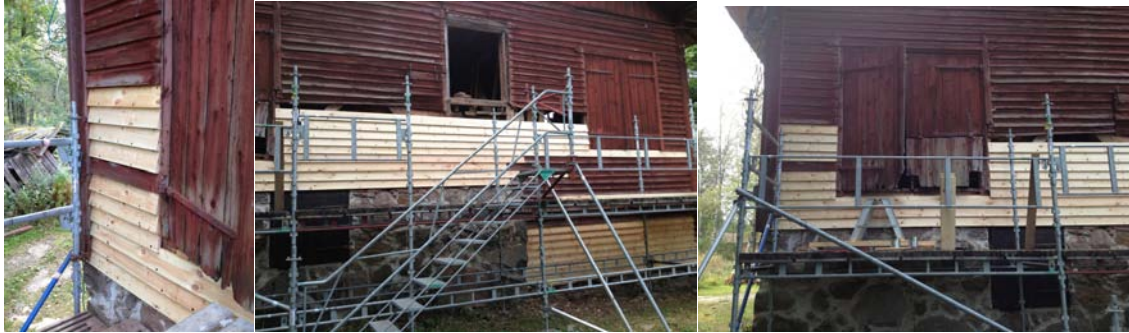
Fortsatt byte av panel längs med östra kortsidan. 2013-09-09 till 12
