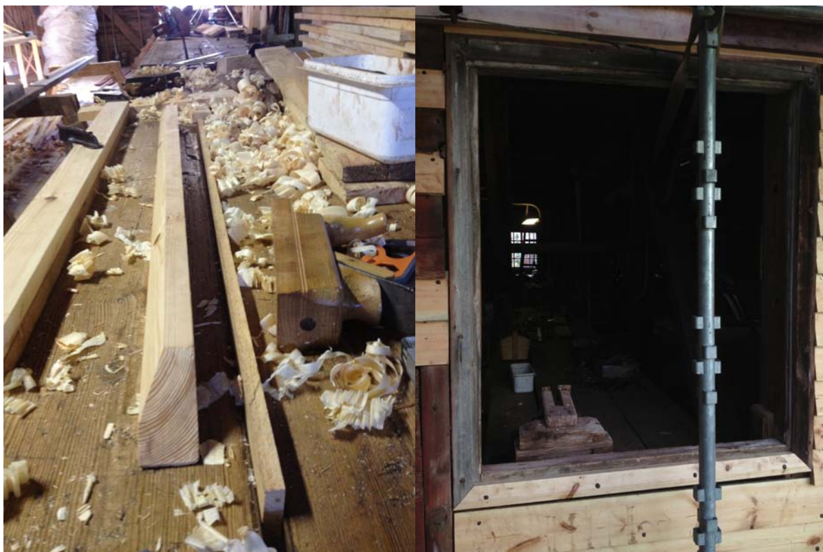
Tillverkning av undre del av fönsteromfattning/utfyllnad på gavelsidan. 2013-09-27
