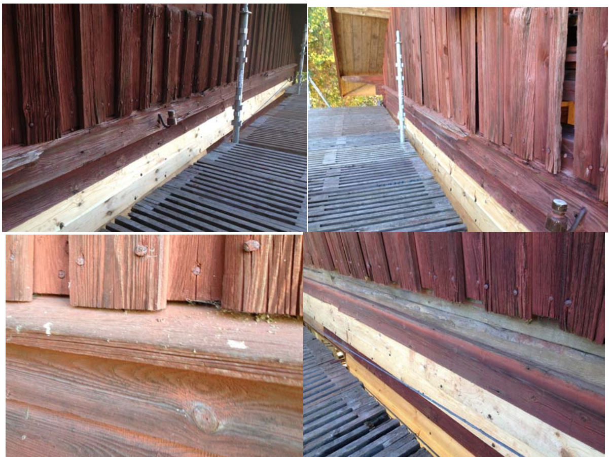
Bilddokumentation över längdskarv vattenbräda. 2013-09-24
