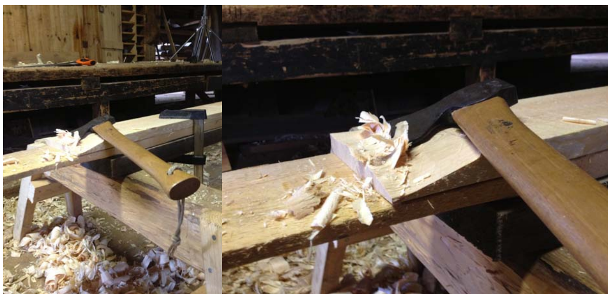
Huggna skarvar för skarvning i längsled. Befintliga skarvar som återfanns på gaveln hade en längd av ca 95 mm och var huggna. Nya skarvar som behövde göras, för att spara så mycket av befintlig panel som möjligt, gjordes med samma storlek och höjgs med yxa. 2013-09-09
