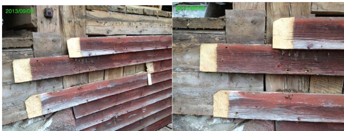
Huggna skarvar för skarvning i längsled. Befintliga skarvar som återfanns på gaveln hade en längd av ca 95 mm och var huggna. Nya skarvar som behövde göras, för att spara så mycket av befintlig panel som möjligt, gjordes med samma storlek och höjgs med yxa. 2013-09-09
