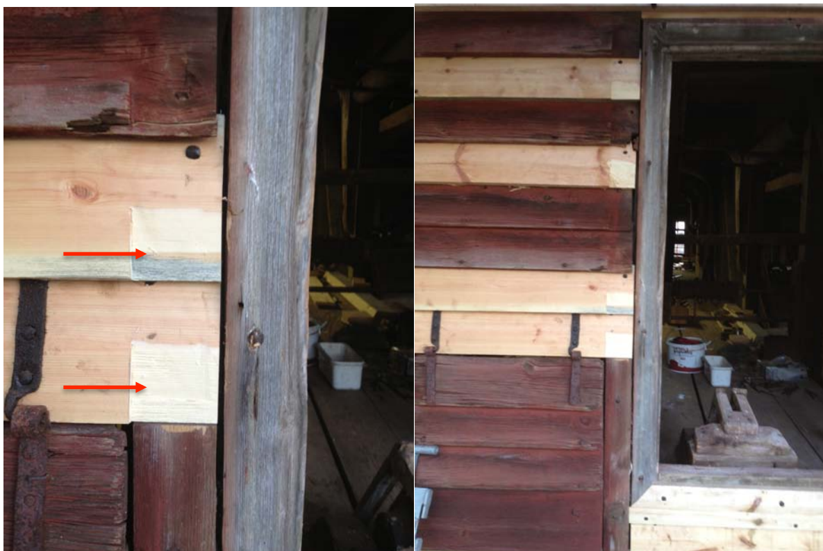
Uthuggning för fönsterfoder i förvandringspanel. Markerat med pilar. 2013-09-27
