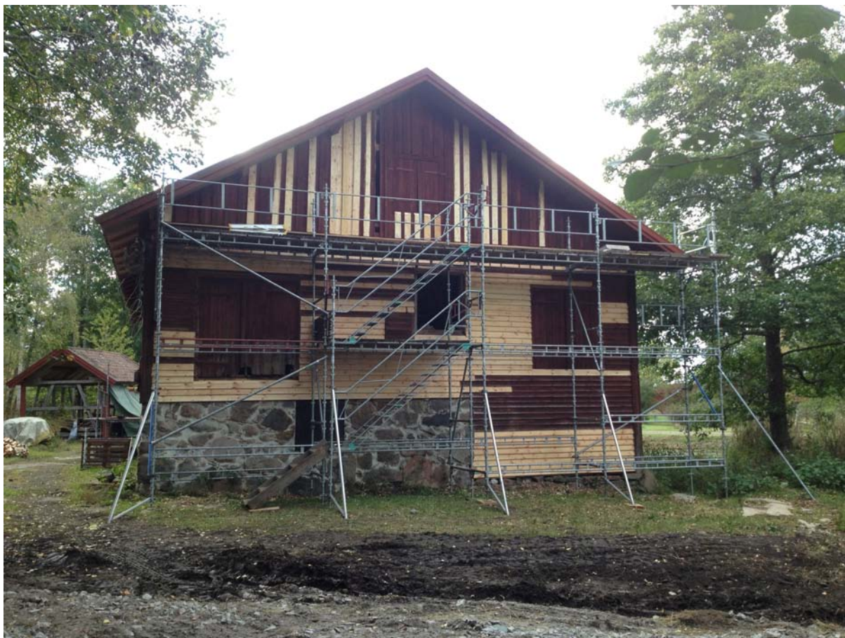
Österängs Ångsåg i slutskedet av restaureringen/renoveringen av östra gaveln 2013
