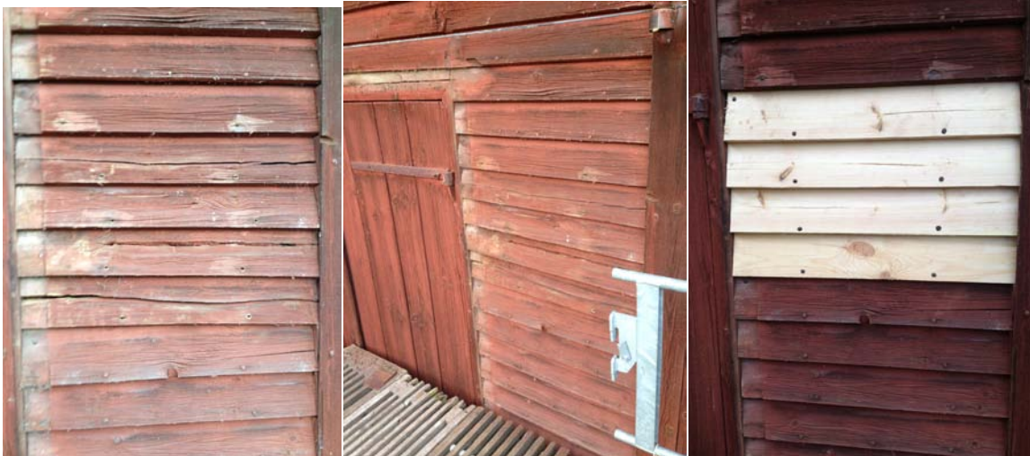
Fortsatt byte av förvandringspanel. Före till vänster och efter till höger. 2013-09-13
