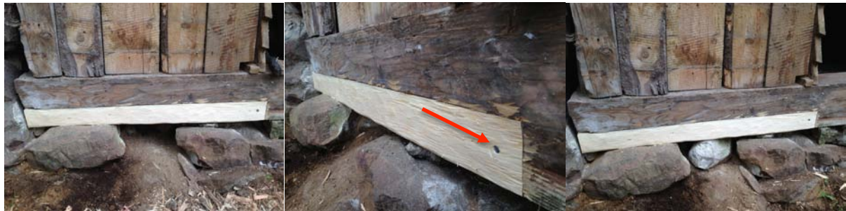
Lusbit ihopskrädd med syll och fast spikad med galvad trådspik 6". Fastspikad främst från bakifrån.
