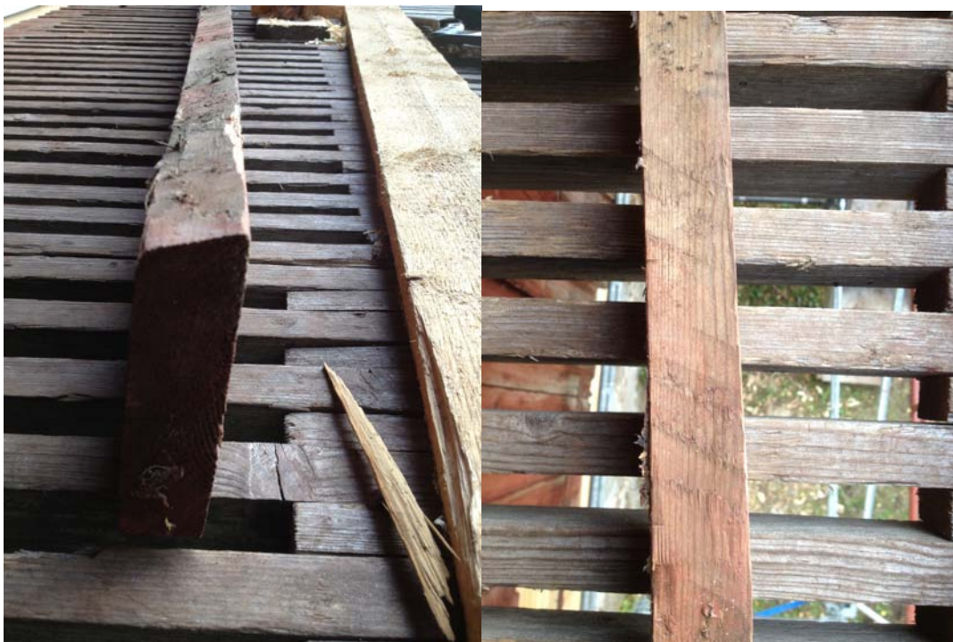
Vattenbrädan borttagen och visade i profil och dess bakkant. Den är arbetad med yxa för att få anslutningen i bakkant vertikal mot stommen/remstycket då den lutar ca 15 grader i fastsatt läge.
