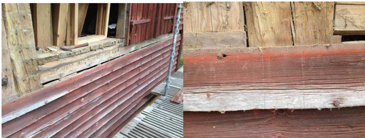
Fortsatt rivning och påritning för skarv av panel i längsled.
