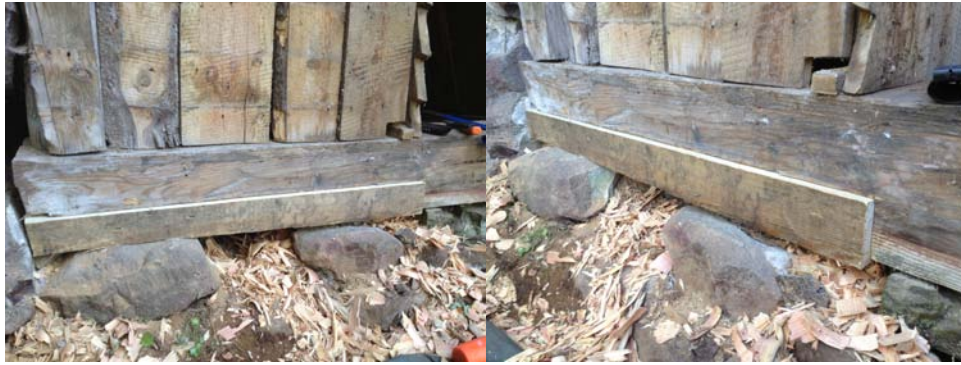
Tillverkad lusbit ca 80x120x1000 mm och infällning i syll. 2013-09-05
