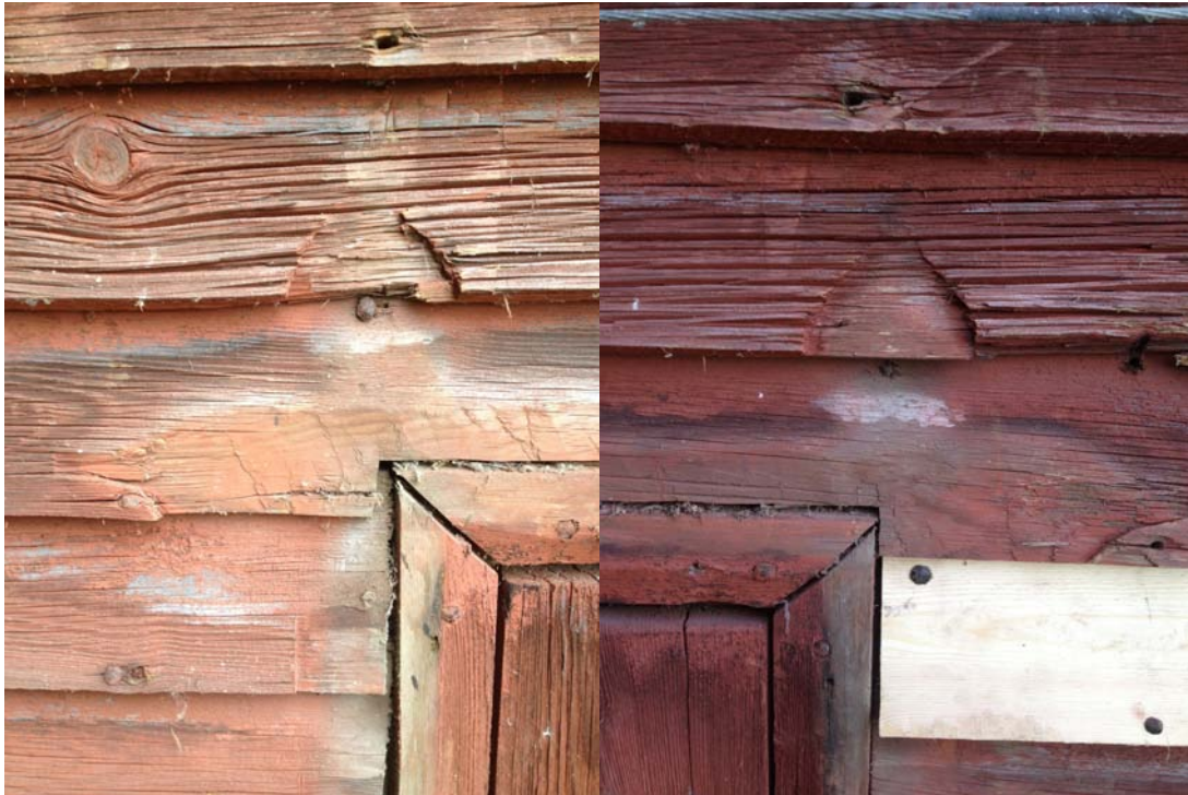
Bilddokumentation av uthuggning i förvandlings panel för foder kring port innan byte av berörd panel.
