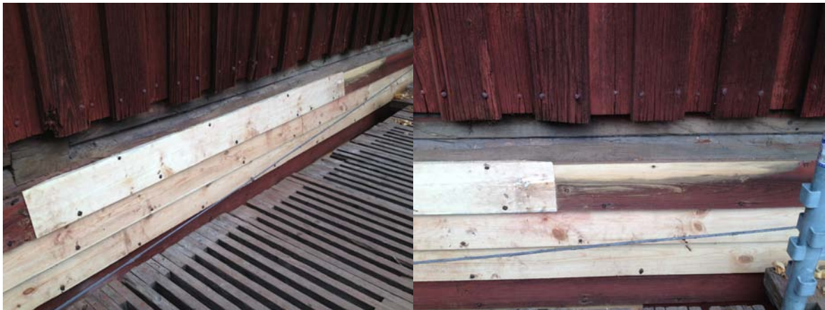
Utbytt panel andra raden under vattenbrädan, i dess fulla längd med överliggande längdskarvar och dess högra skarv i närbild. Mötet sammanarbetat med hyvel.
