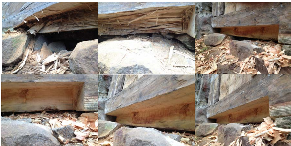
Borthuggning av rötangripet material i syll. Renhuggning för lusning av syll. 2013-09-04 till 05
