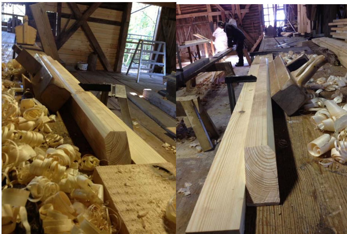
Tillverkning av undre del av fönsteromfattning/utfyllnad på gavelsidan. 2013-09-27
