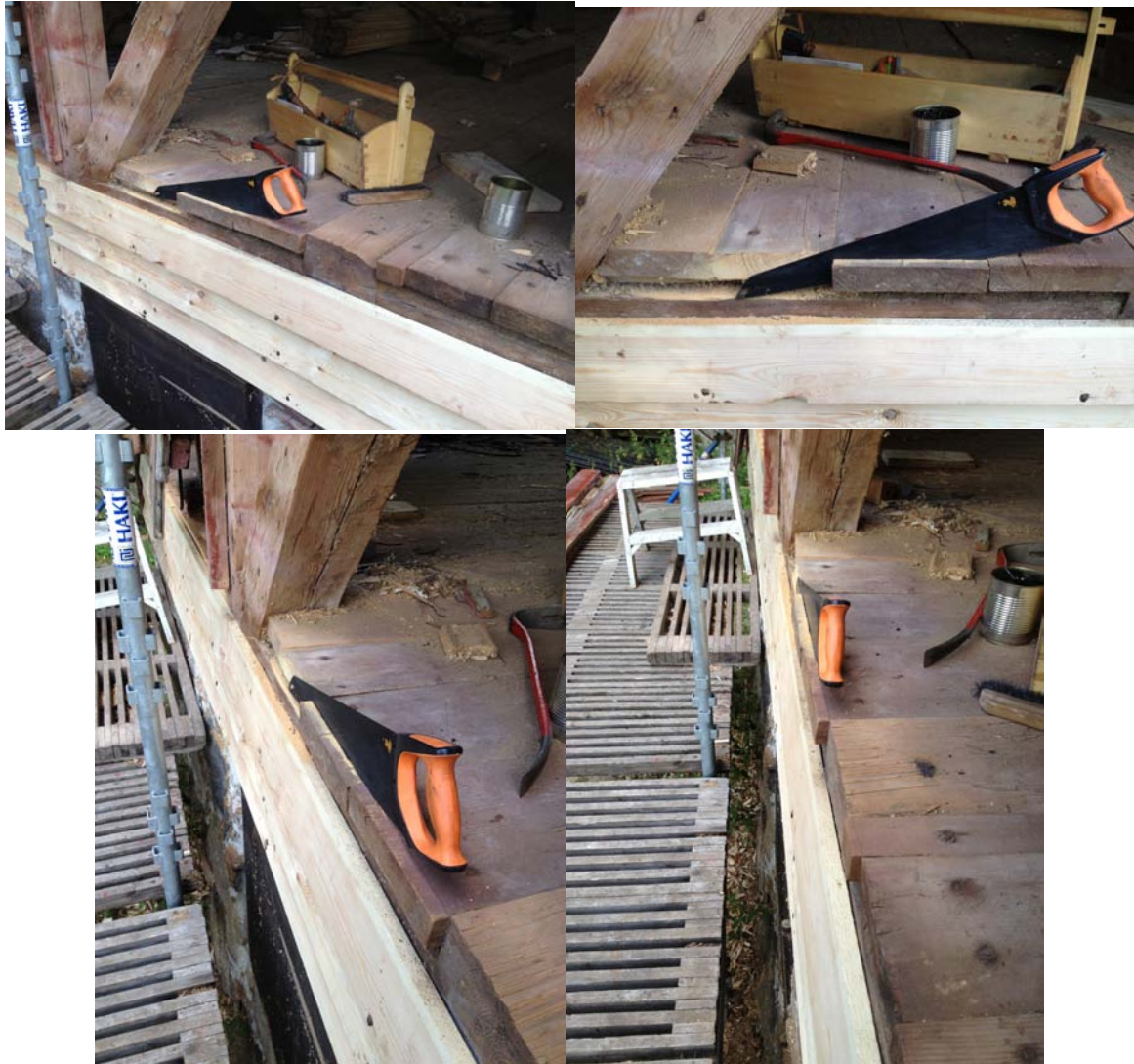
Kapning av befintliga golvplankor som hade kommit för långt ut mot ytterväggen vid golvrestaureringen tidigare år. Kapning för att skapa en rak linje för förvandringspanelen att ligga an mot.
