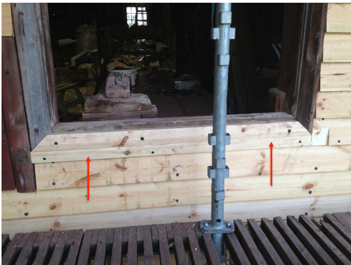
Tillverkning av utfyllnad mellan fönsterfoder och panel. Visad med pilar. 2013-09-27
