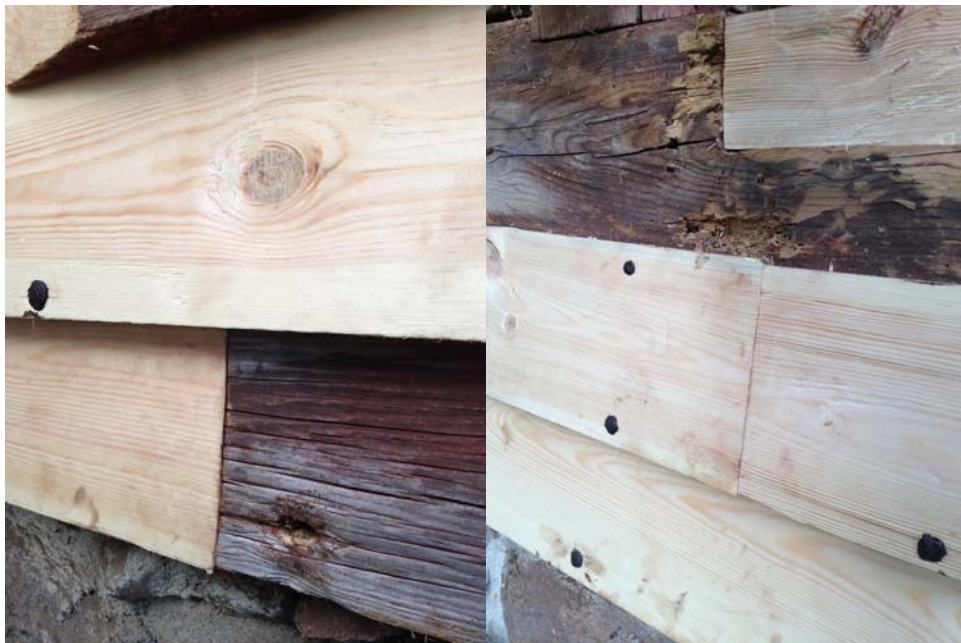
Nygjorda skarvar både med ny till befintlig och ny till ny panel.
