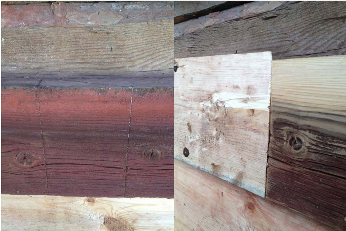
Längdskarv på panelbrädor andra raden under vattenbrädan, påritning och färdigskarv. 2013-09-24
