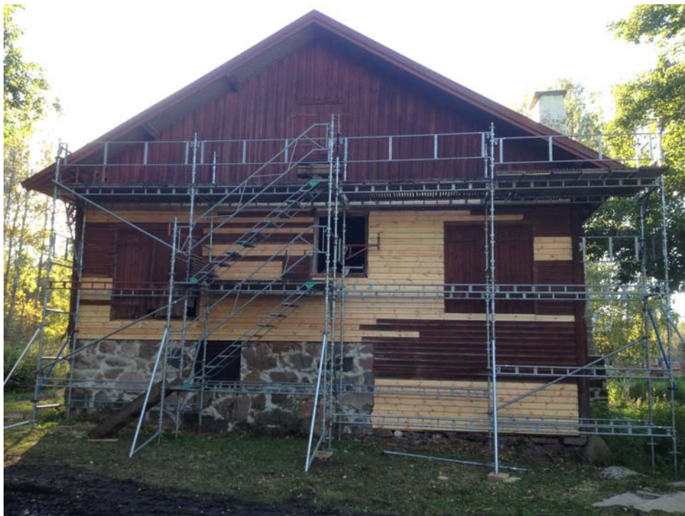
Bilddokumentation av östra gavelsidan under arbetsgång. Ställningen uppbyggd till sista etappen av restaureringen i höjdled, de stående panelbrädorna. 2013-09-23
