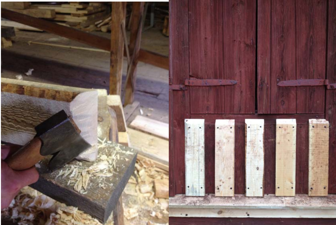
Byte av ståendepanel under port på gaveln. Dessa var fasade för vattenavrinning i ovankant och för bättre motstånd vid in och uttagning av material genom porten. 2013-09-26
