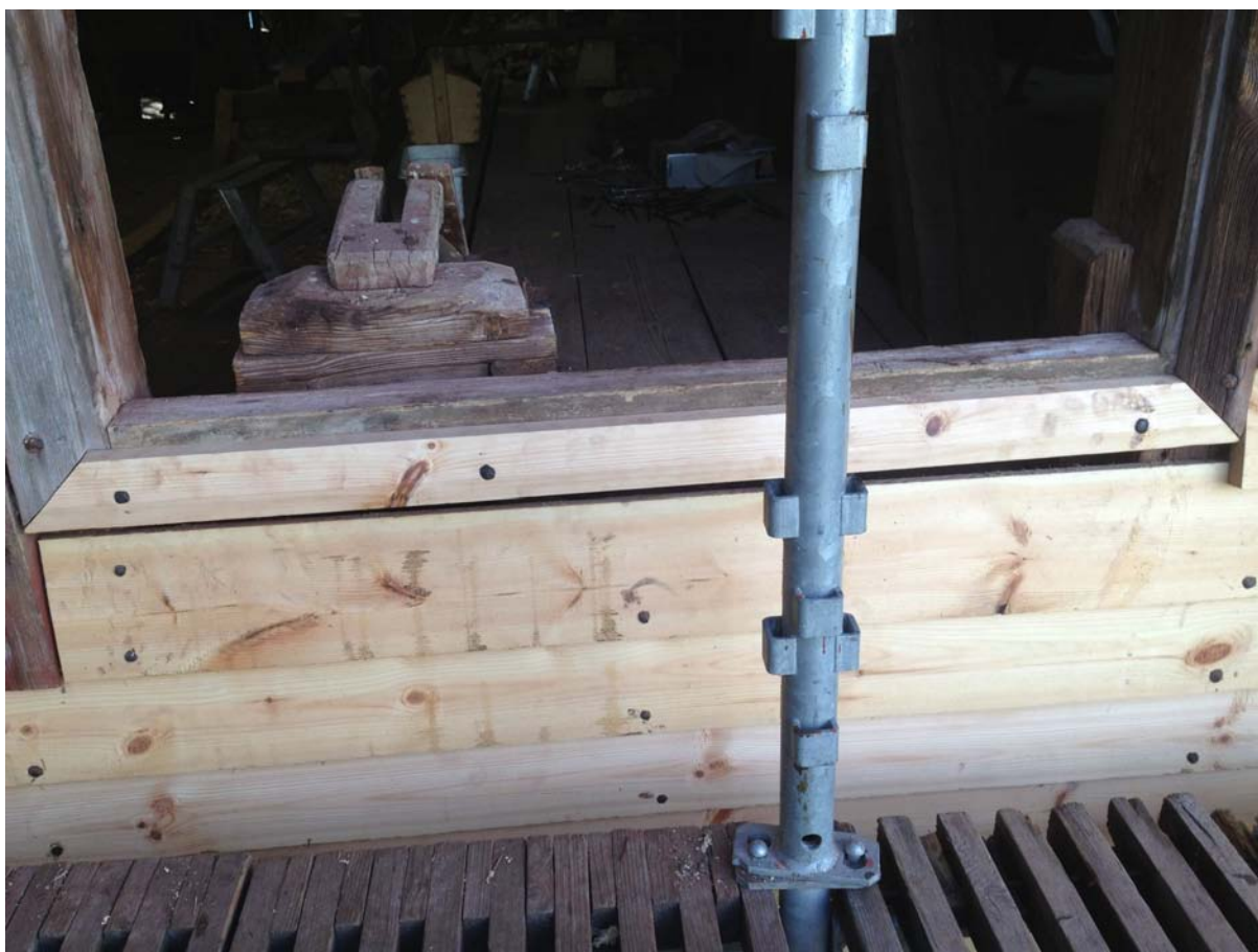
Tillverkad underdel till fönsteromfattning fastspikad med smidda spik. 2013-09-27
