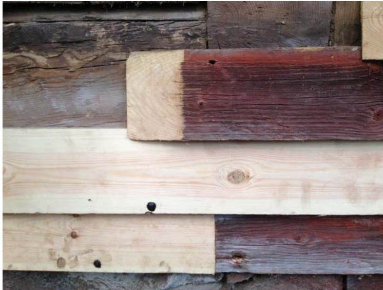
Överlappning av skarvlängder.
