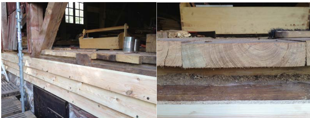
Efter kapning visar snittytan den goda kvalitén på virket som valdes till golvplankor och dess kondition efter många års nötande och utsatthet. Denna del av plankan har vett mot den skadade och utslitna panelen. Där väder och vind har utsatt virket.
