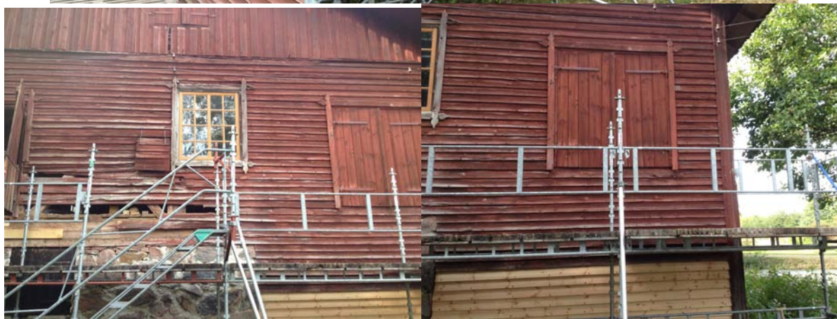
Bilddokumentation inför fortsatt rivning. 2013-09-07
