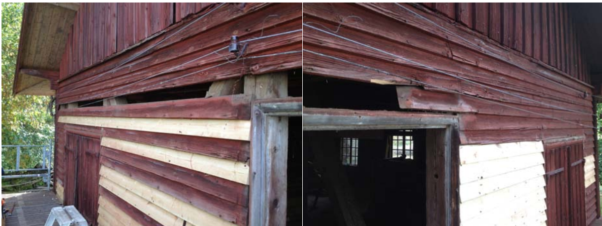
Bilddokumentation av östra kortsidan på pågående arbete och inför fortsatt byte av panel. 2013-09-18
