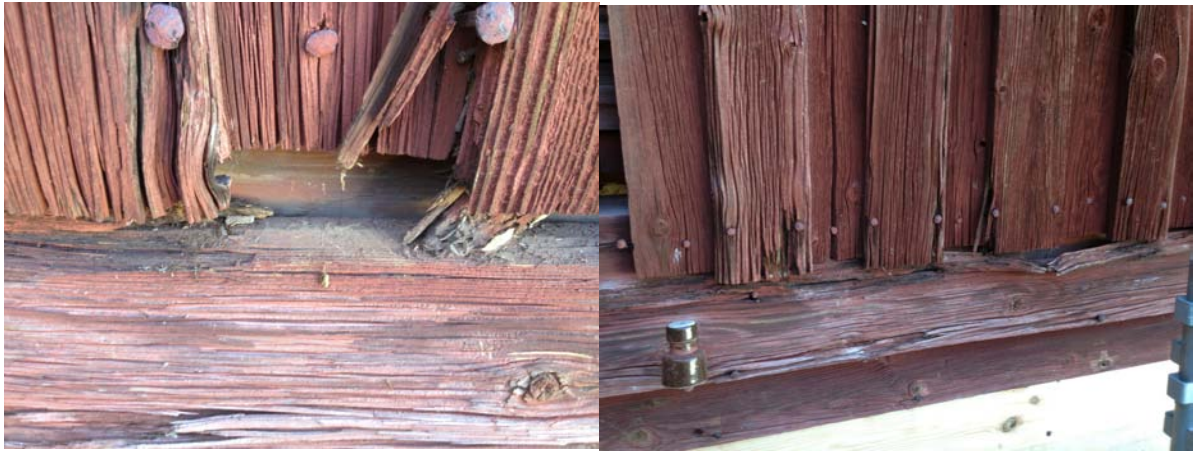
Bilddokumentation av möte vattenbräda och stående panelen på gaveln, inför åtgärd av och p.g.a. undersökning för val av ersättningsvattenbräda och beredning av den. 2013-09-24 till 25
