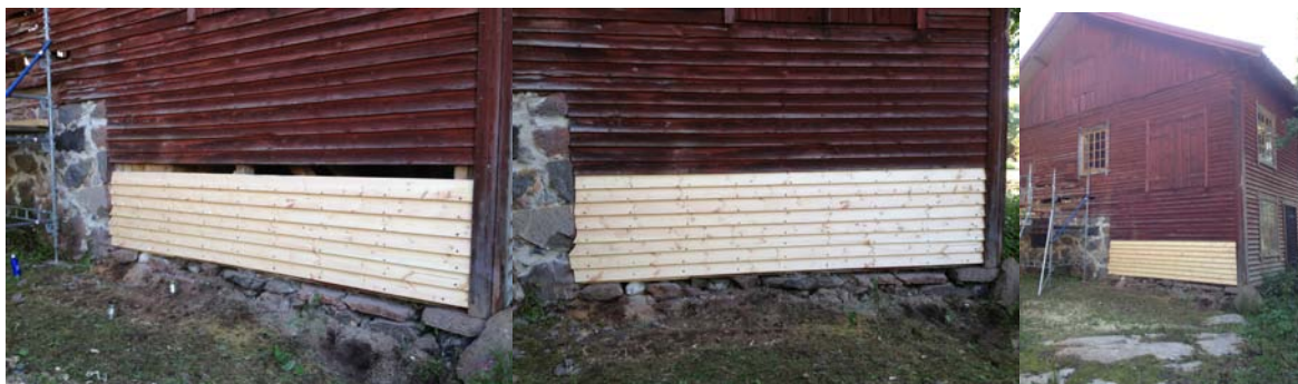
Efter lagad syll spikas ny förvandringspanel upp. All panel byts p.g.a. av stora skador. Panelen oxhyvlades och spikades med återvunnen smidd spik från denna och tidigare rivningar. 2013-09-06
