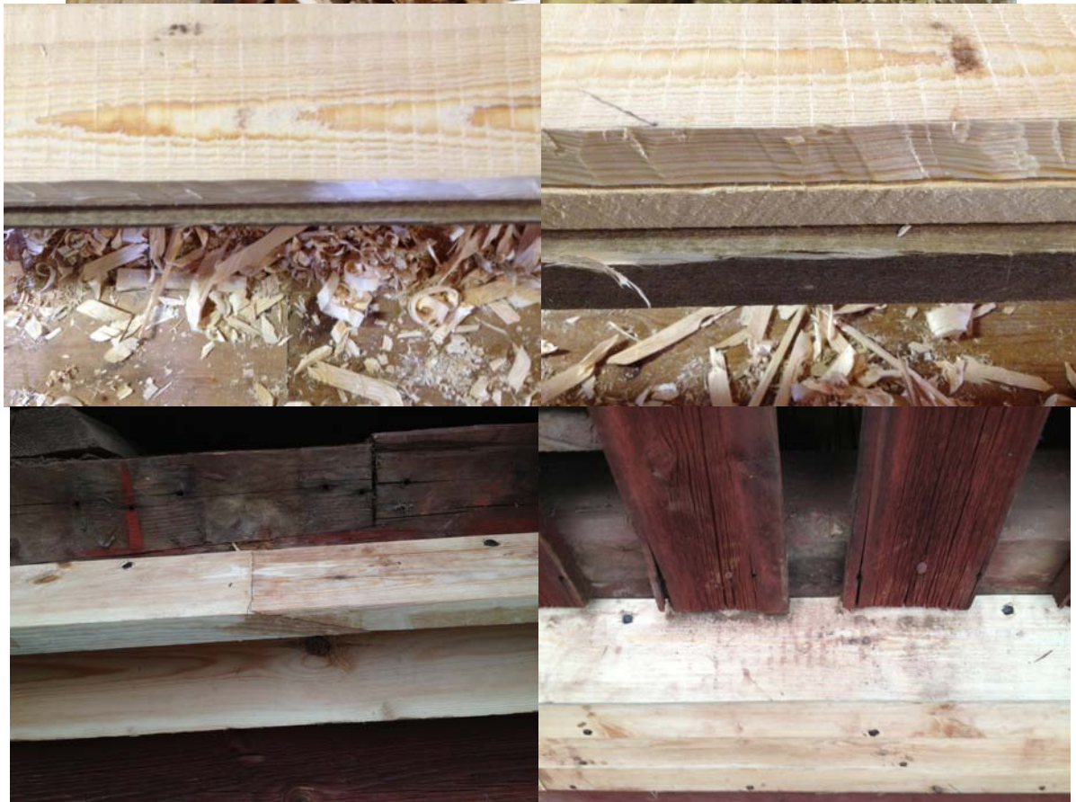
Bilder på huggning av vattenbrädans fasning, andra sättet. Vattenbrädan i förhållande till den undre riktbrädan, färdig längdskarv på vattenbrädan och hur den är fastspikad.
