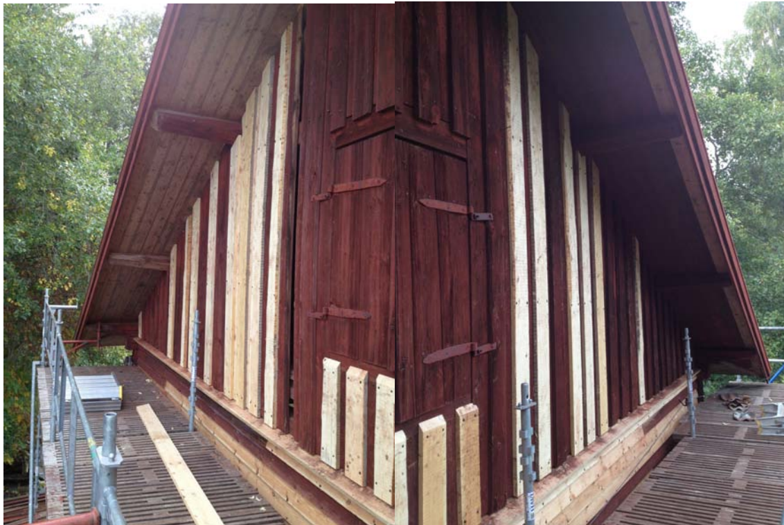
Bilddokumentation av utbytta stående gavelpanelbrädor. 2013-09-27
