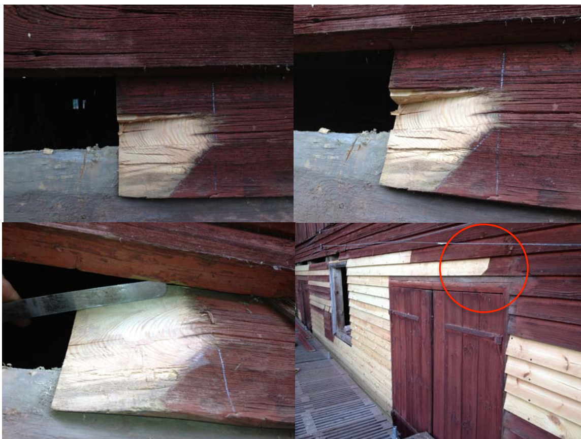
Bildserie av tillverkad panelskarv ovan högerport östra gavelsiden. Berörd skarv markerad. 2013-09-19
