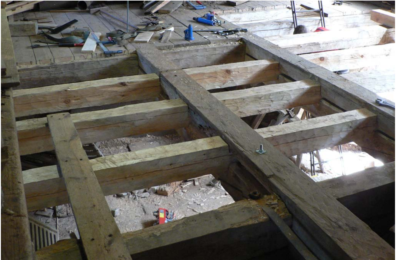
Bild 25 Renoverat golvbjälklag på sågvind
