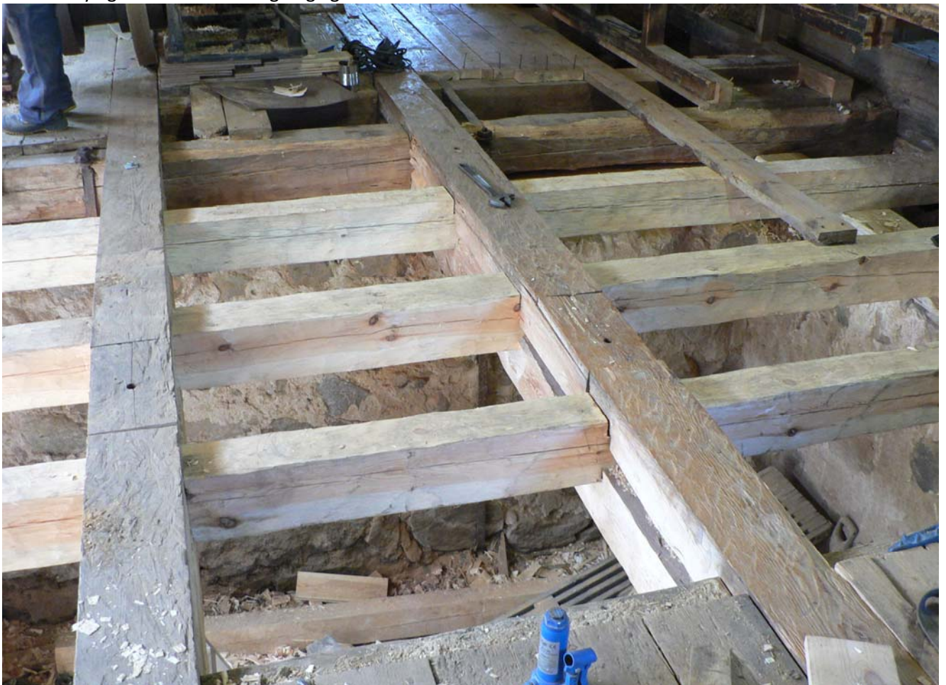
Bild 24 Återlagda "rälsstockar" på de ny tillverkade golvsstockarna
