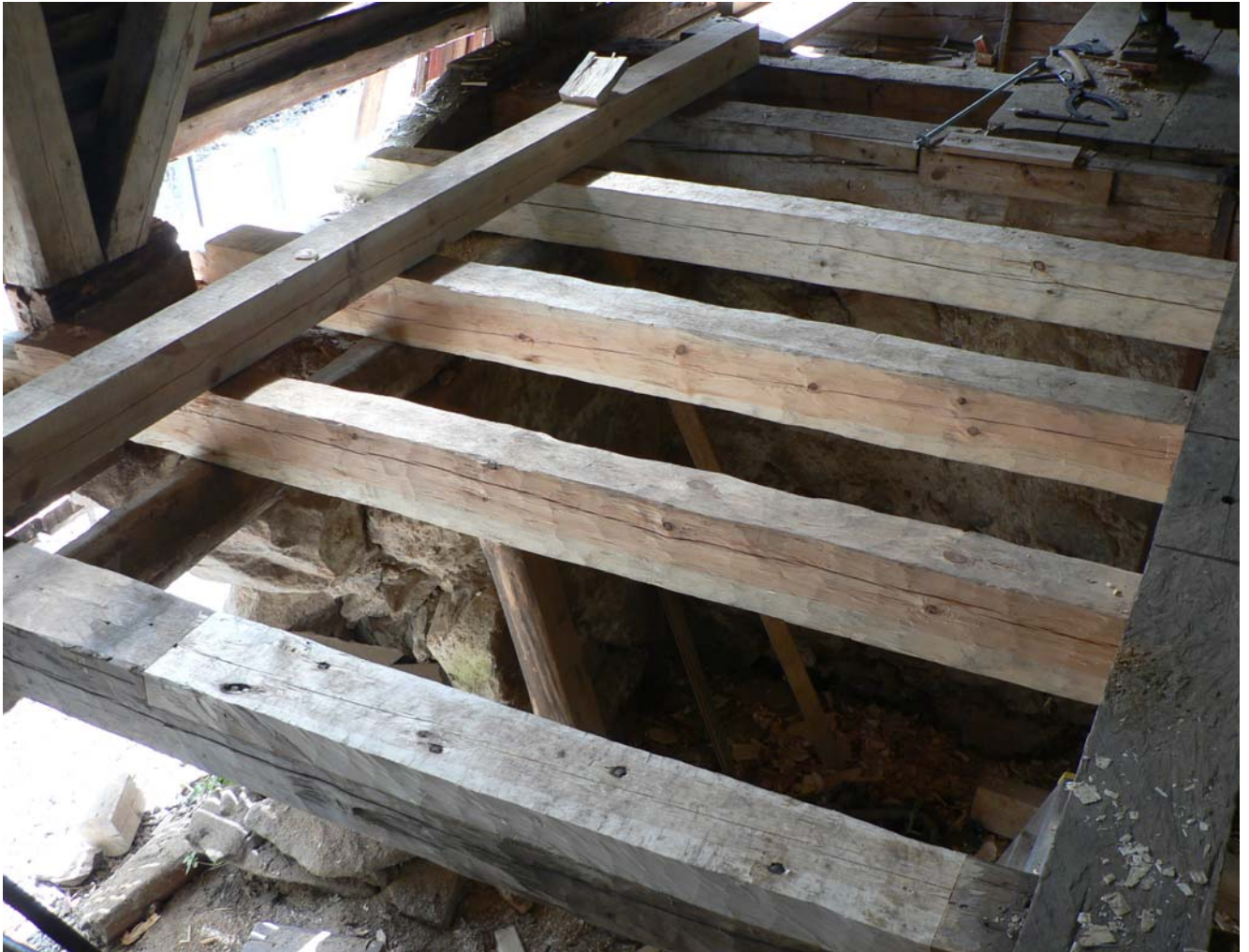
Bild 23 Nya golvsstockar samt lagning i golvsstock
