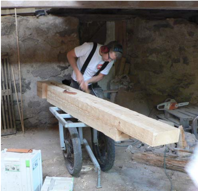
Bild 14 Skrädning av ny del till syll (under ram)
