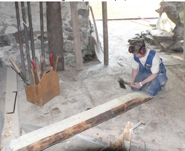
Bild 16 Ny syll till sågvindsgolv (under kantbänk)
