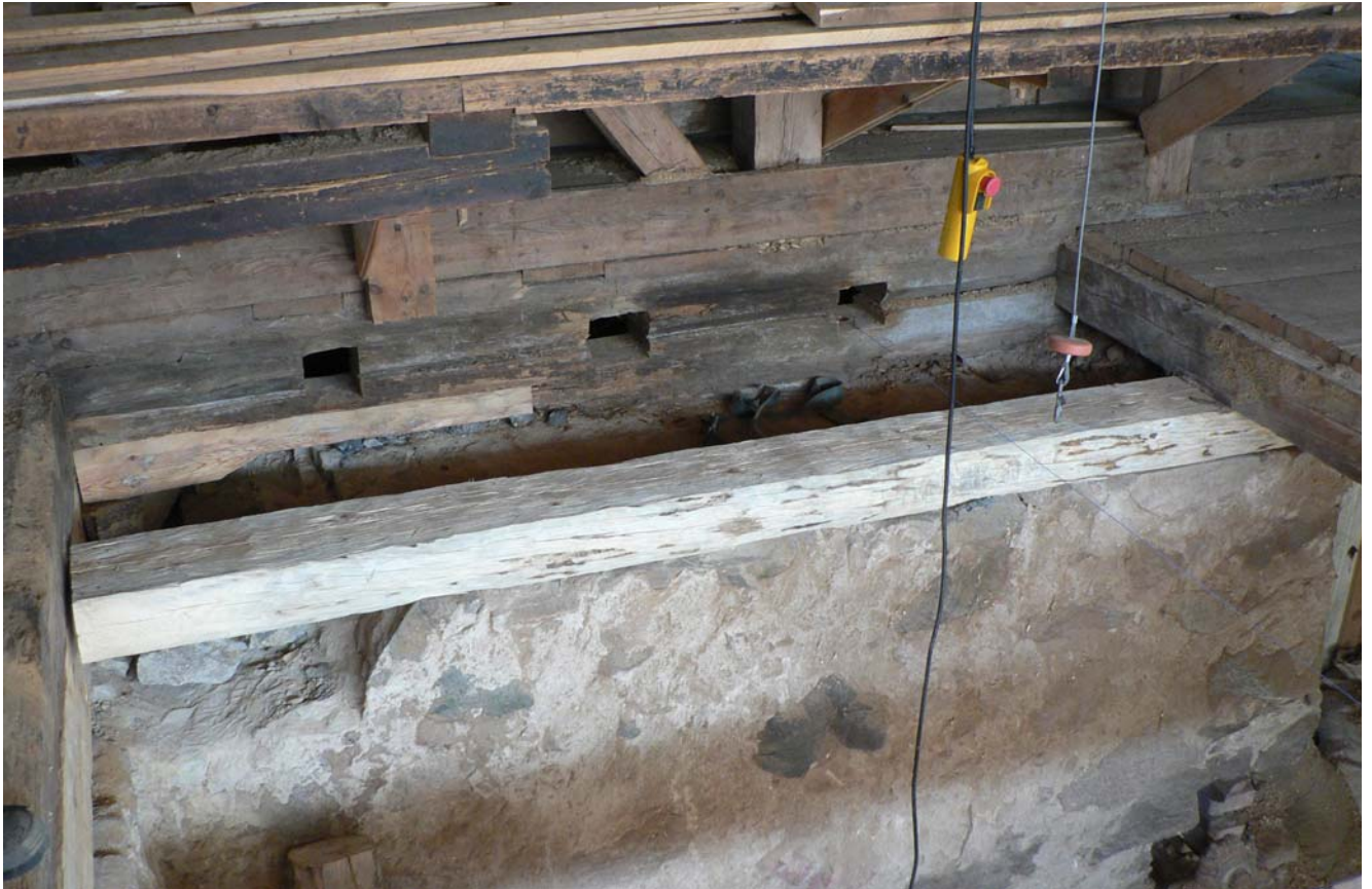
Bild 21 Utbytt och lagad syll på mittväggsmur.
