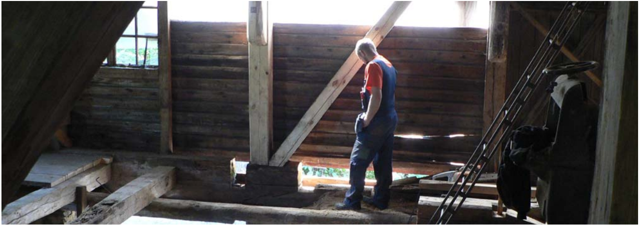
Bild 27 Rötskadad övre och undre syll på sågvind, mot söder.
