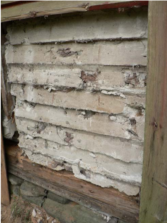
Bild 35 Igenmurat fack. Randningen som syns är från förvandlingspanelens baksida.
