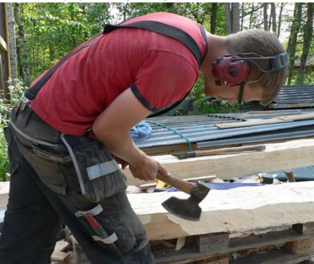
Bild 19 Tillverkning av ny del till syll under kantbänk.
