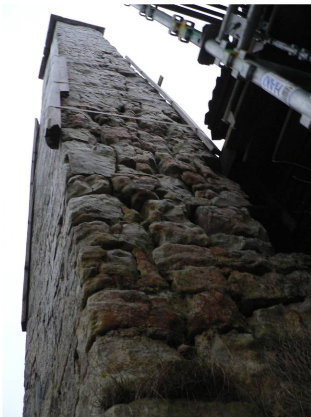
Bild 3. Västra sidan av skorsten
