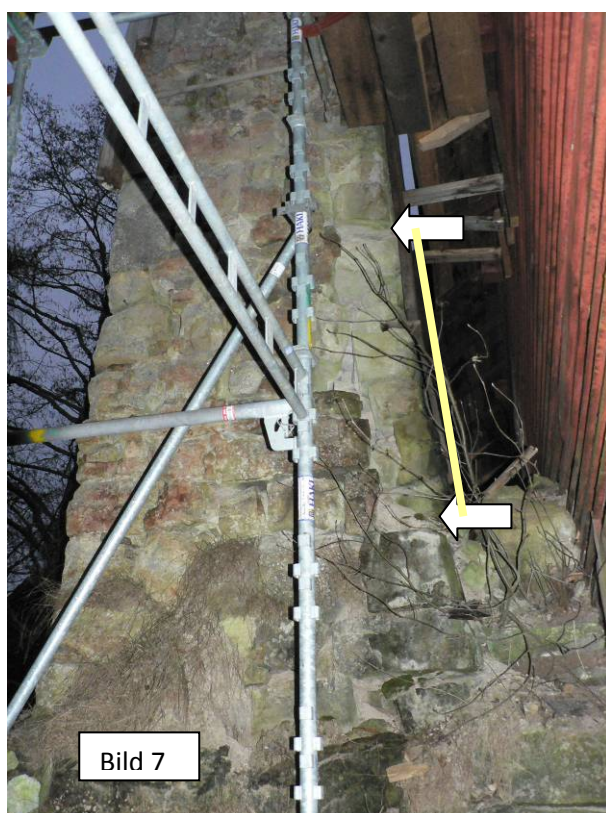
Bild 5 – 7. Sydvästra hörnet med det rasade och utarmade området
