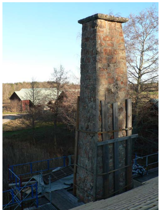
Bild 4. Västra och södra sidan
