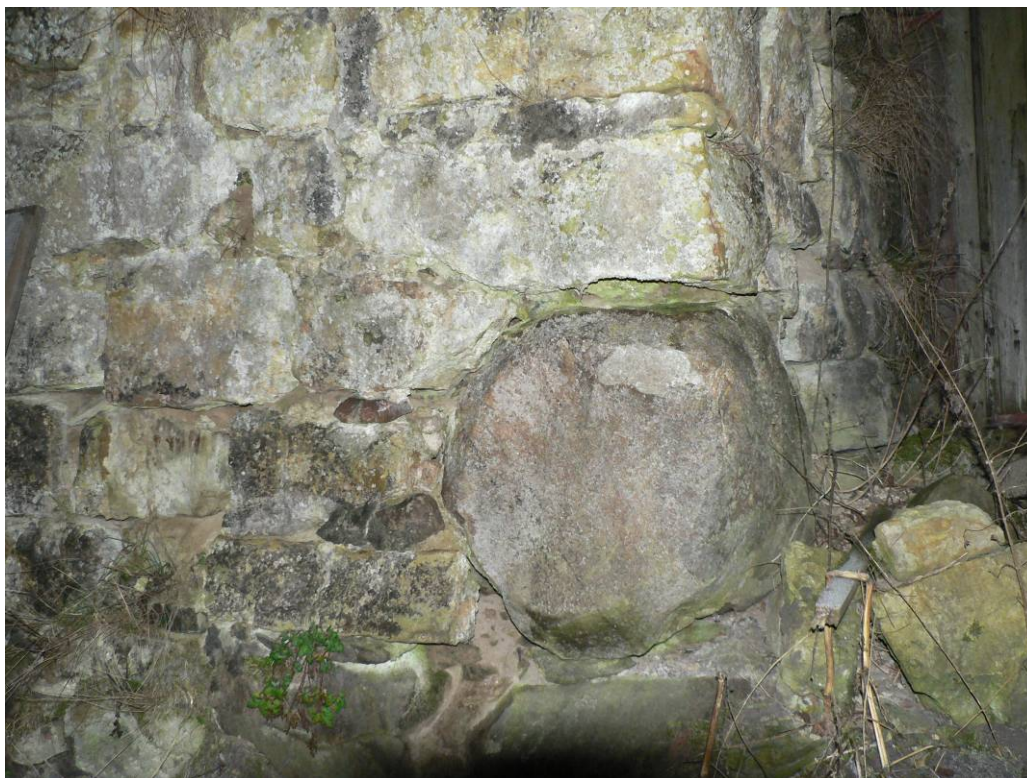
Bild 13. Granitblock i fundament
