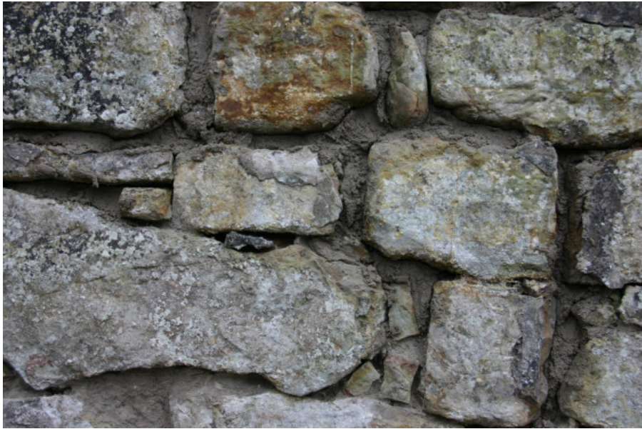
Fogarna håller på att fyllas, vilket sker i etapper.
