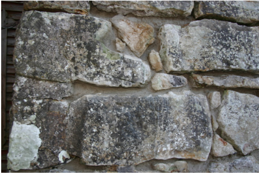
Detalj av fogarna med nytt kalkbruk. Ytterligare bruk appliceras.
