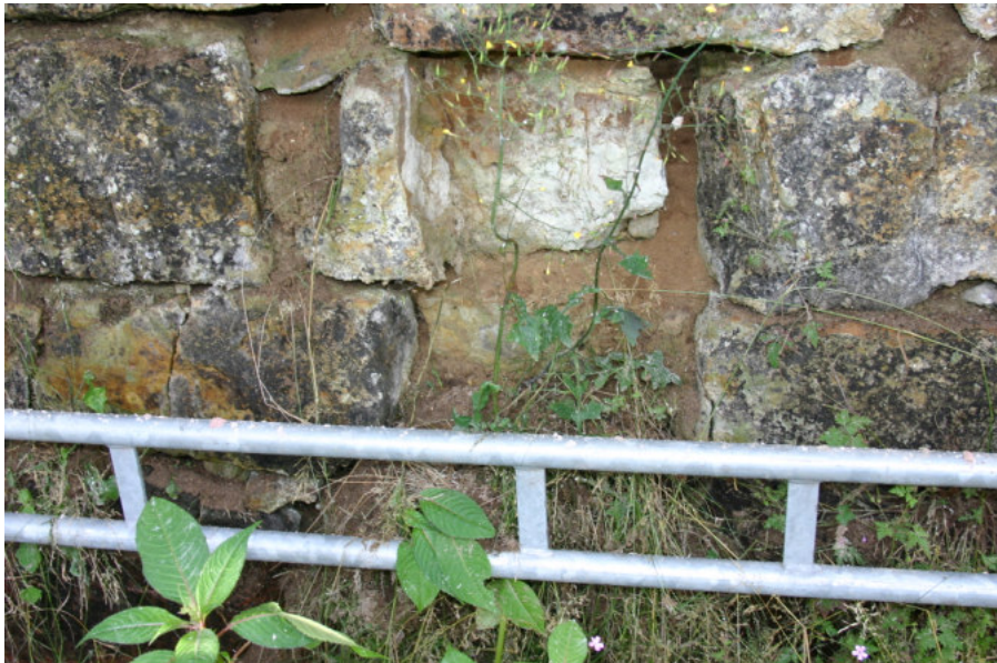
Marknivån är hög runt sockeln.
