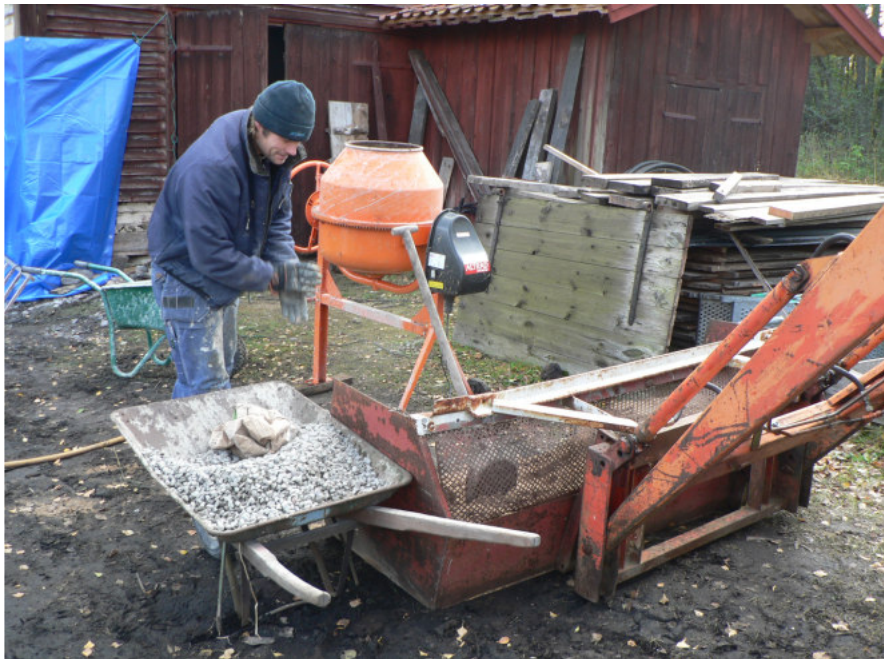
Kalkbruket blandas med ballast i form av 8-16 mm sållat tvättat grus. Foto Erik Bergholtz.
