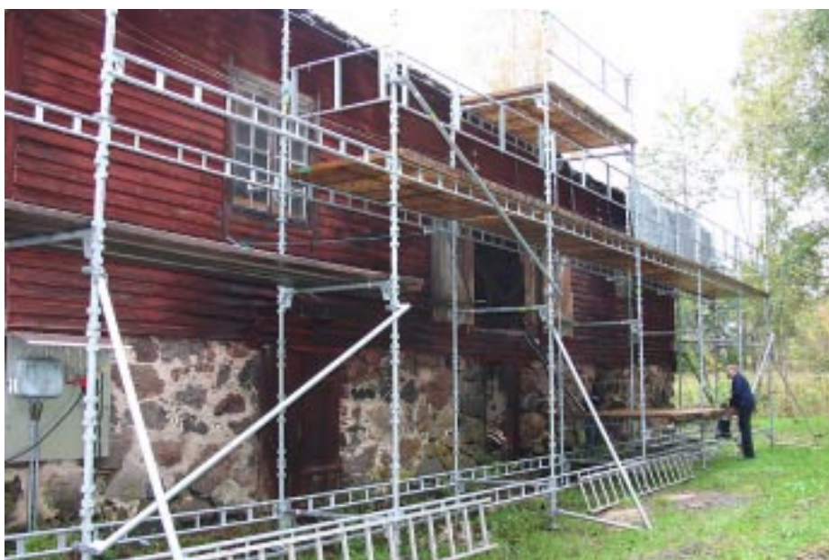
Byggnadsställningarna på plats.
