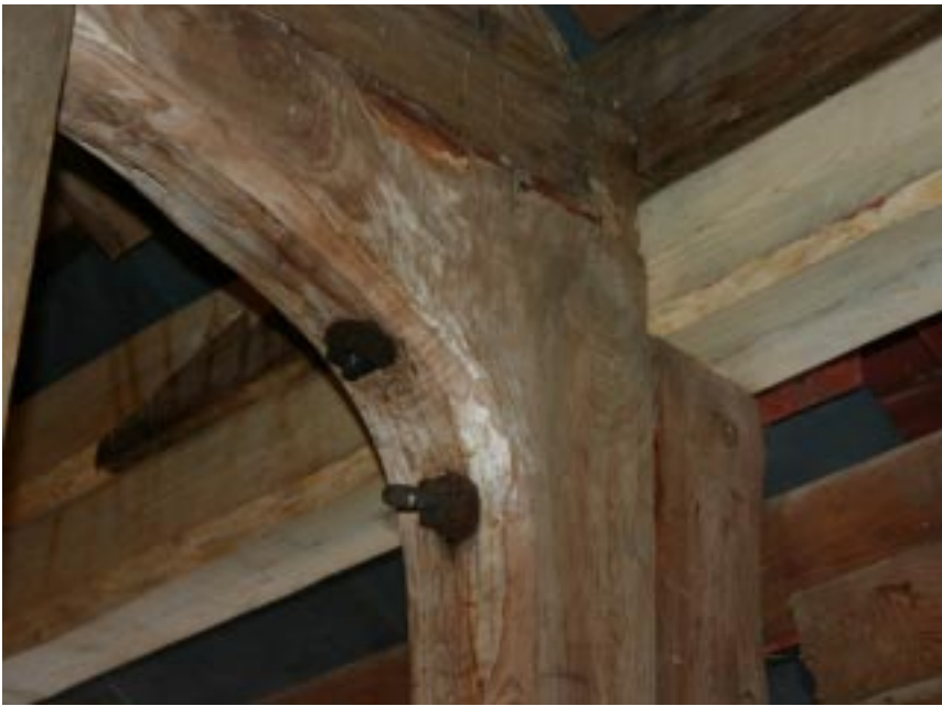
Befintligt rotknä med utbytt nedre hammarband. I bakgrunden skymtar det nya övre hammarbandet med blixtskarv.
