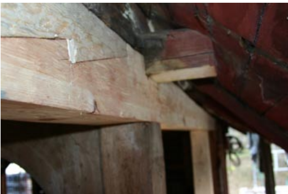
Nedre hammarband med blixtskarv. Foto från byggnads- ställningen.
