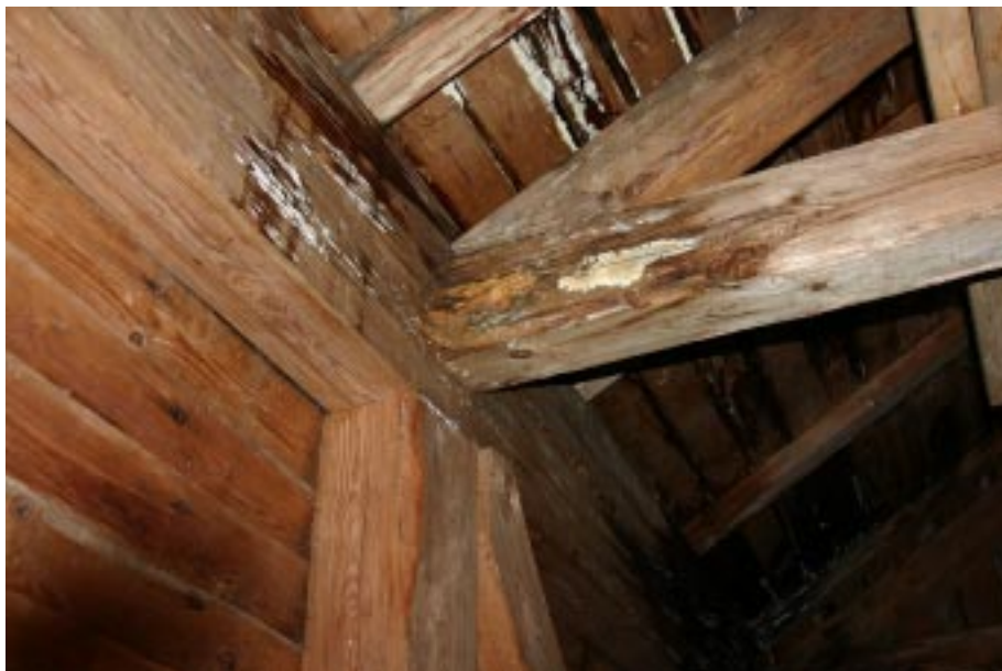
Här monterades senare det nya rotnät som förstärkning av konstruktionen.
