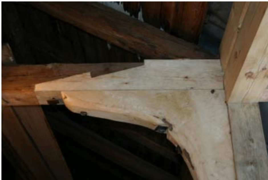
Delar av takstolen vid hammarband och rotknä fick bytas ut.
