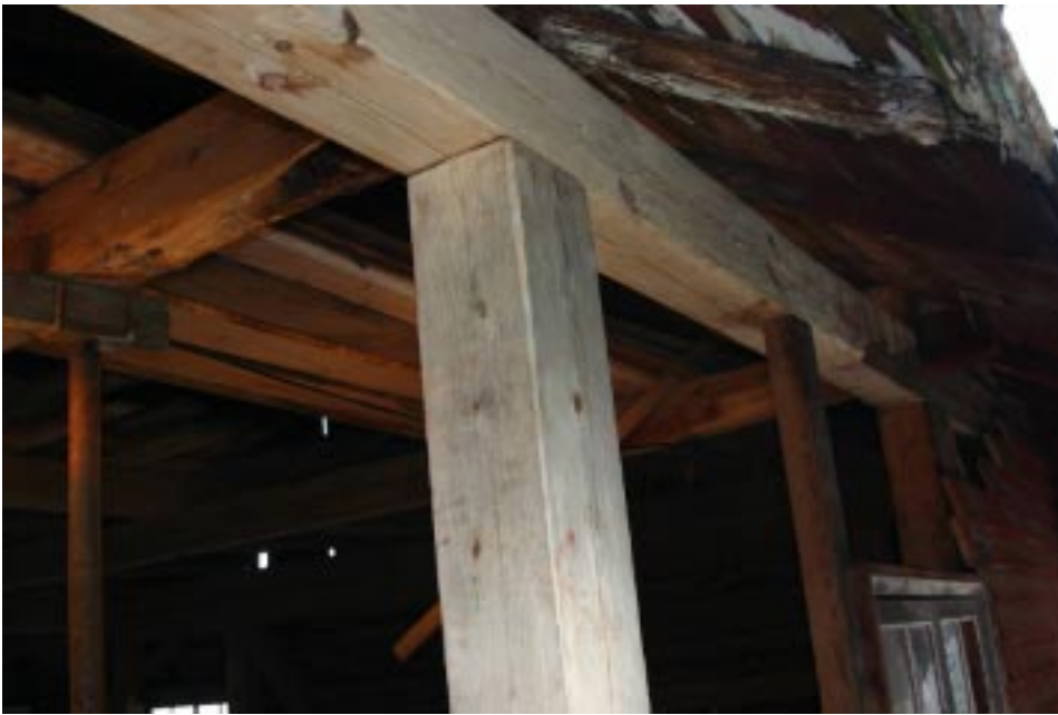
Ny stolpe och nytt hammarband. Foto från byggnads- ställningen.
