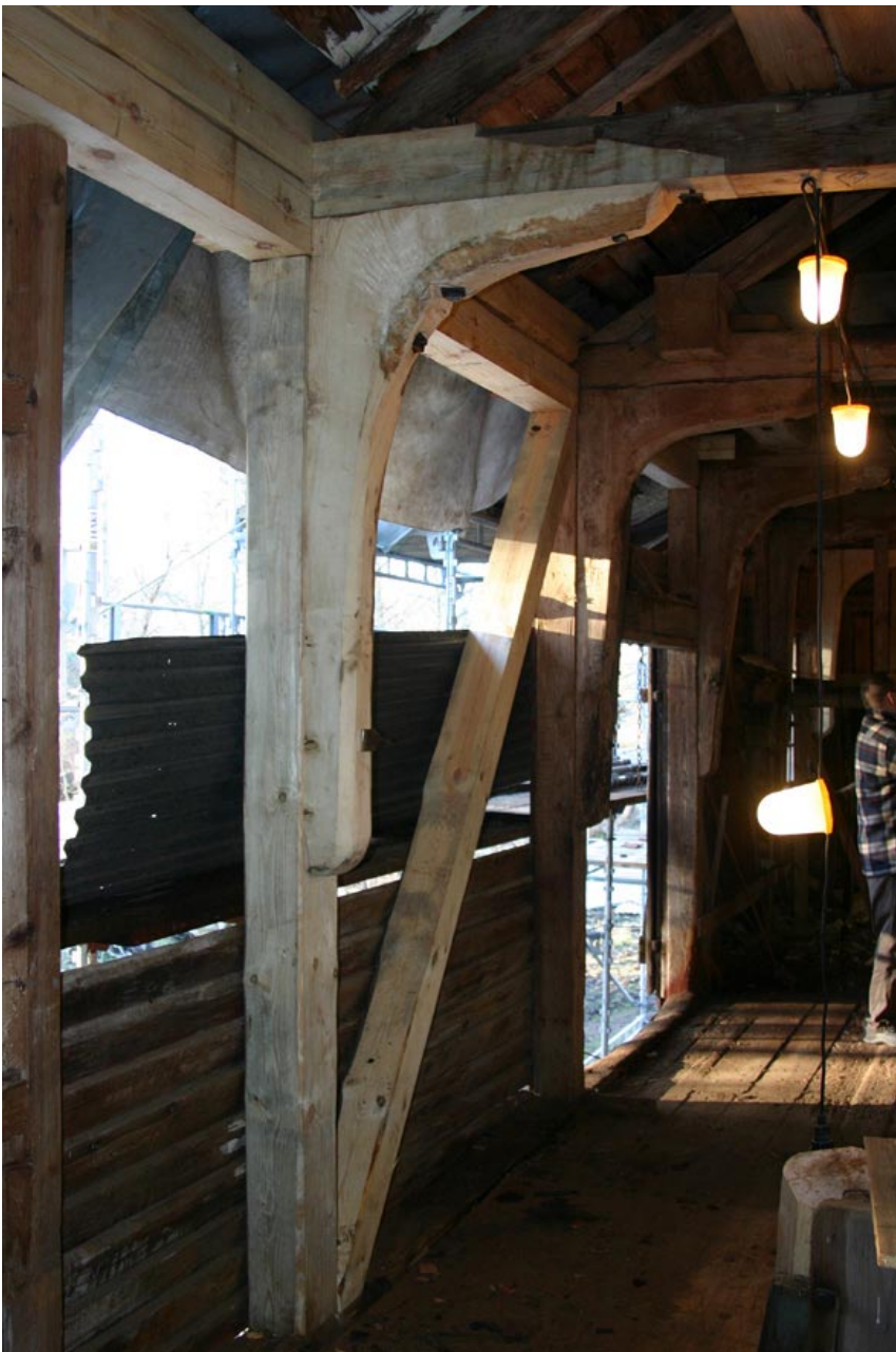
Monterat och klart. Panelen sätts på plats vid ett senare tillfälle.
