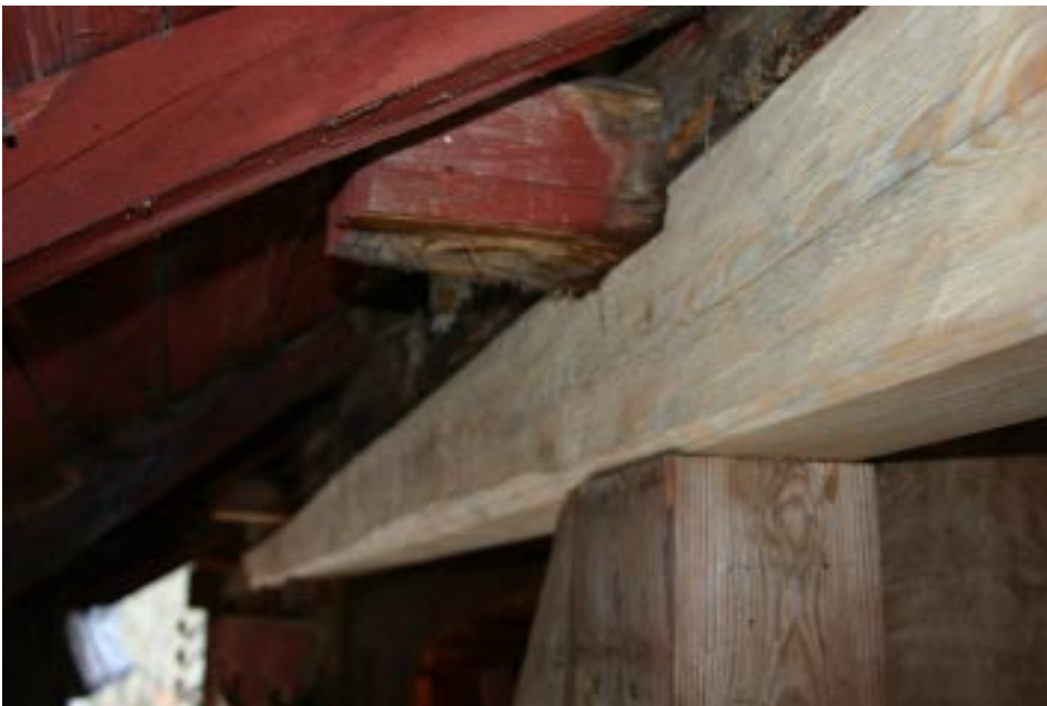
Nedre hammarbandet. Utsidan är skradd och insidan hyvlad i enlighet med original- utförandet. Foto från byggnads- ställningen.
