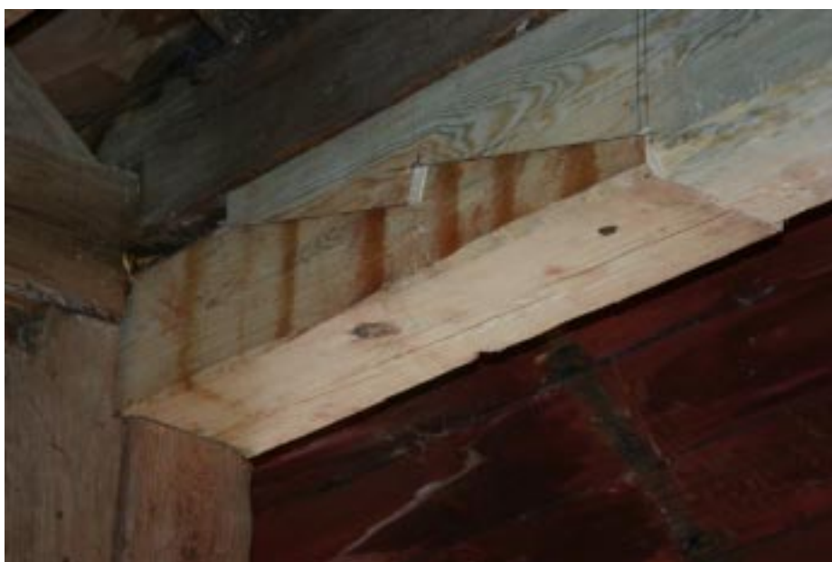
Blixtskarv på nedre hammarband. Denna skarv är ny och fanns inte på det ursprungliga hammarbandet.
