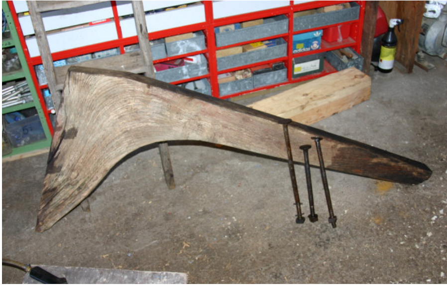
Ett rotknä från cikelsågsbyggnaden som kommer att ersätta det utdömda rotknät. Bultarna är oljade och klara för återanvändning.
