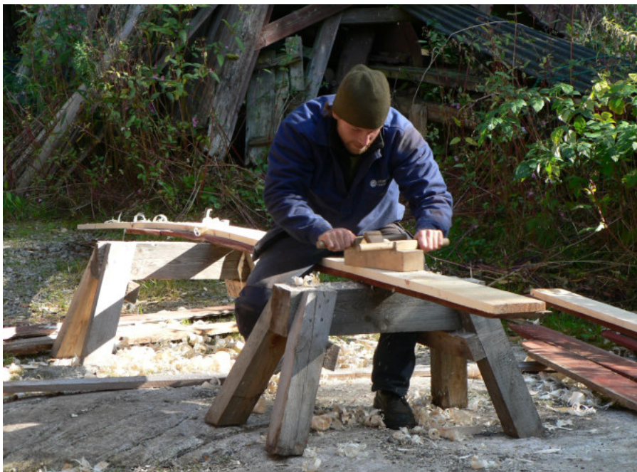
Den nya panelen hyolas för att få rätt mått. Foto Erik Bergholtz
