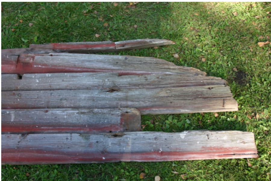
En del av förändringspanelen som tidigare suttit på den norra sidan. Mycket av panelen kommer att åter användas men nya panel-längder är inköpta.
