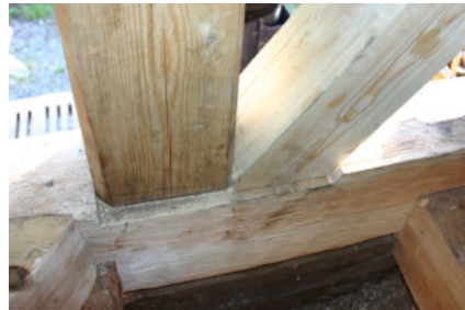
Two bilder med uttag och hopfogning på den södra sidan.
