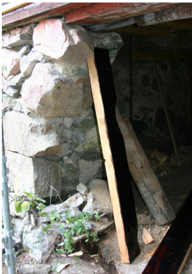
Tre karmstycken har tagits fram till den högra dörren i den södra fasaden. Sidostyckena tappas i det befintliga överstycket, se nästa sida, och till det nytillverkade understycket, se ovan till höger. Ytan som kommer att ligga mot murlivet har tjärats.
