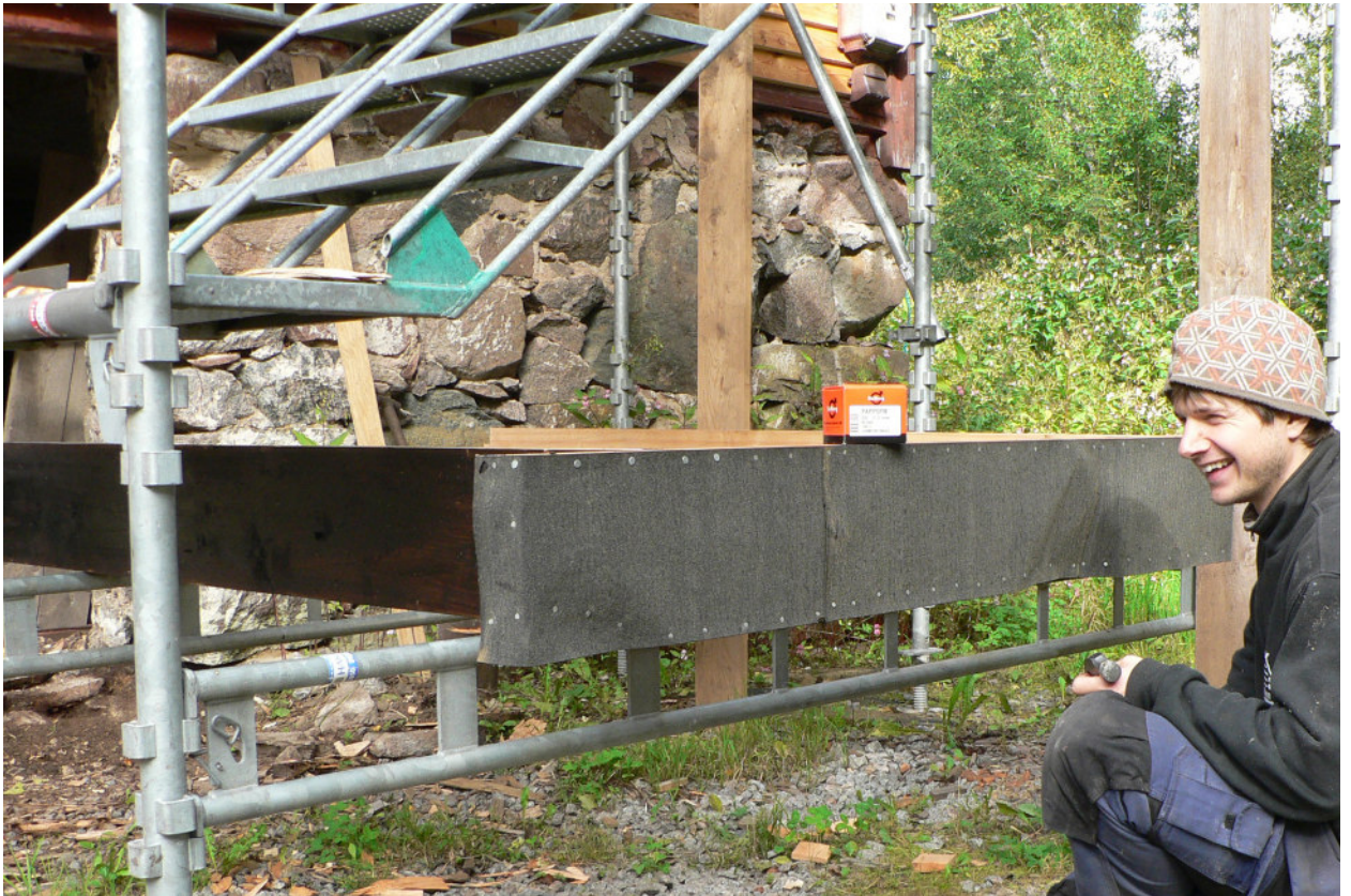
Dörrkarmen hopsatt och undersidan klädd med tjärpapp. Foto Erik Bergholtz.
