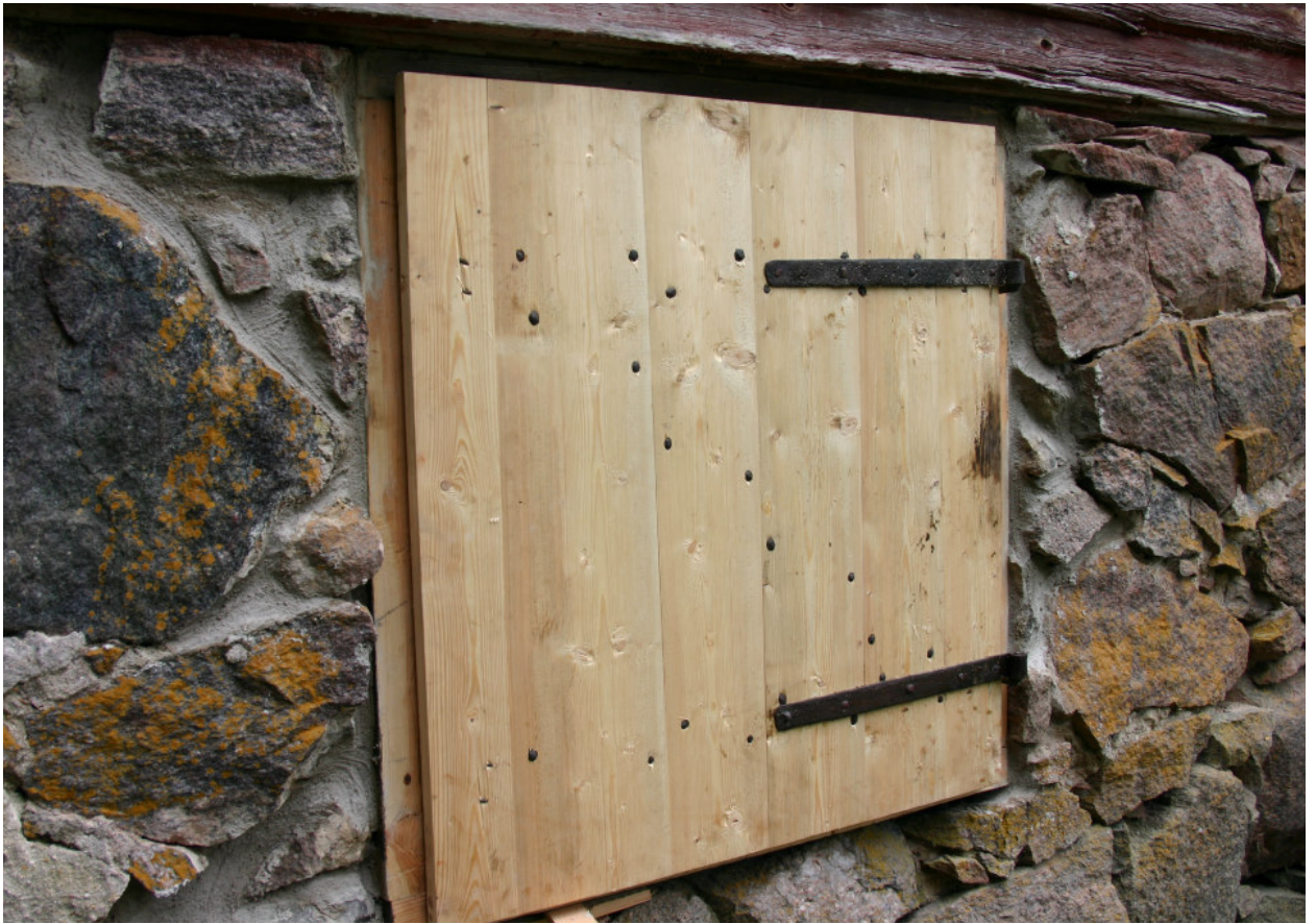
Luckans in- och utsida. Karmen har också kompletterats, endast överstycket gick att återanvända (se föregående bild). Den gamla luckan har använts som mall och beslagen har flyttas över från den gamla. Smidda spiken fäster brädorna vid nar och tvärslä.
