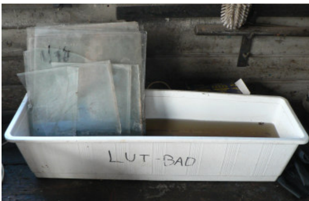
Rengöring av glastrutorna - från gammalt kitt och färg - med kaustik-soda. Foto Erik Bergholtz.
