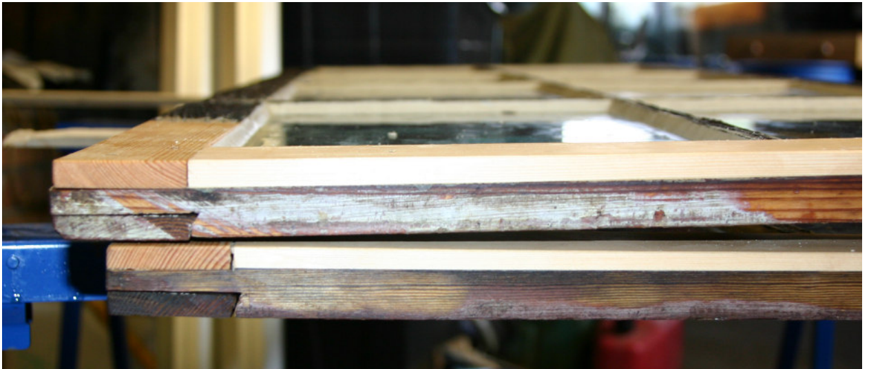
Halvsulning av ett par bågar.
