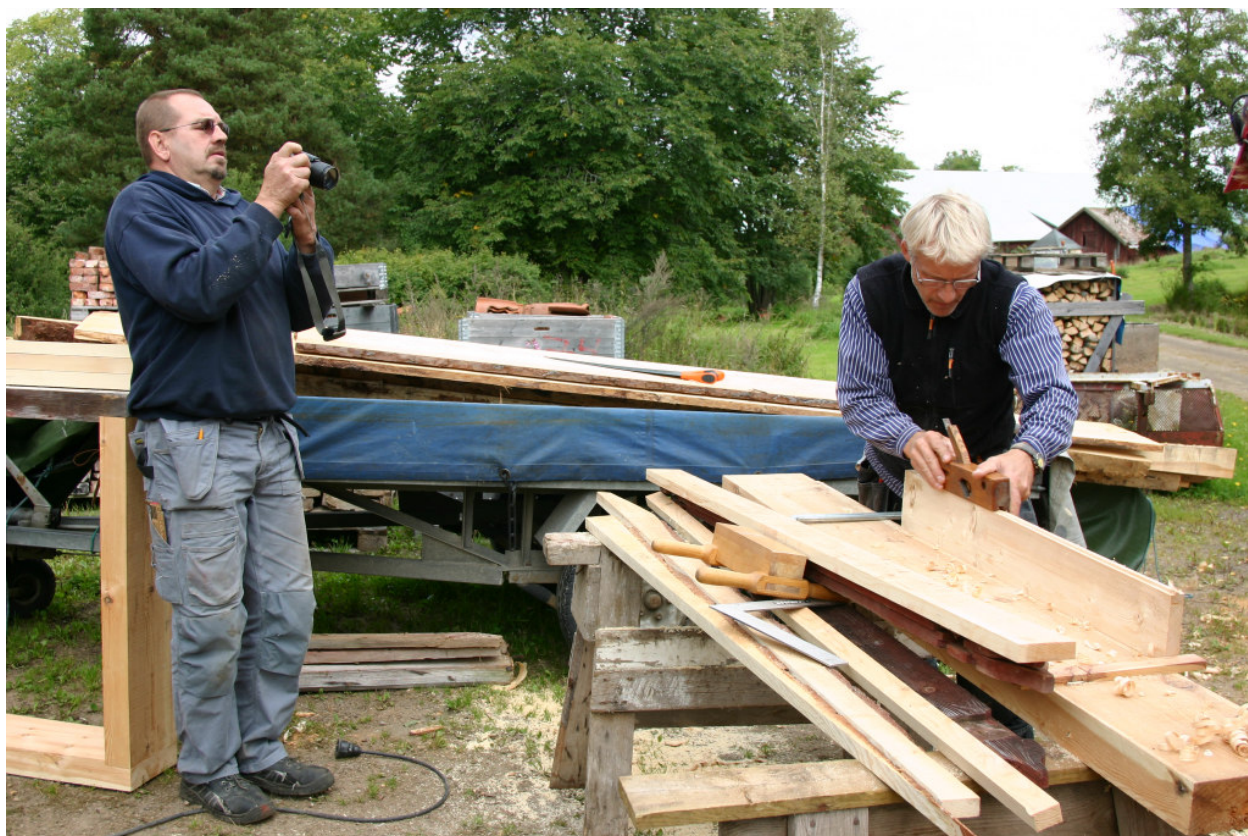
Erik Bergholtz fotograferar Fred Lagnemar när han hyvlar fjäder till den lucka som ska snickras. Dörrbräderna tas fram på samma sätt.
