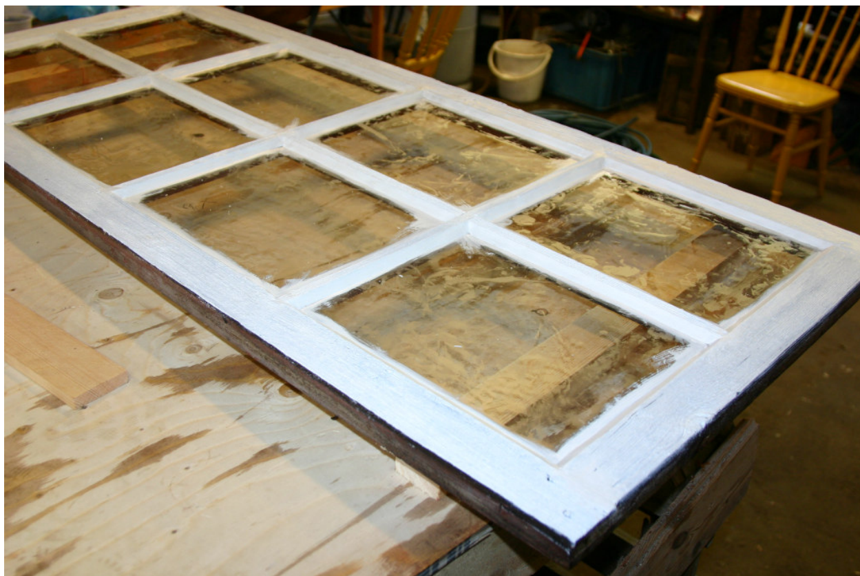
En båge är renoverad förutom färdigmålning.
