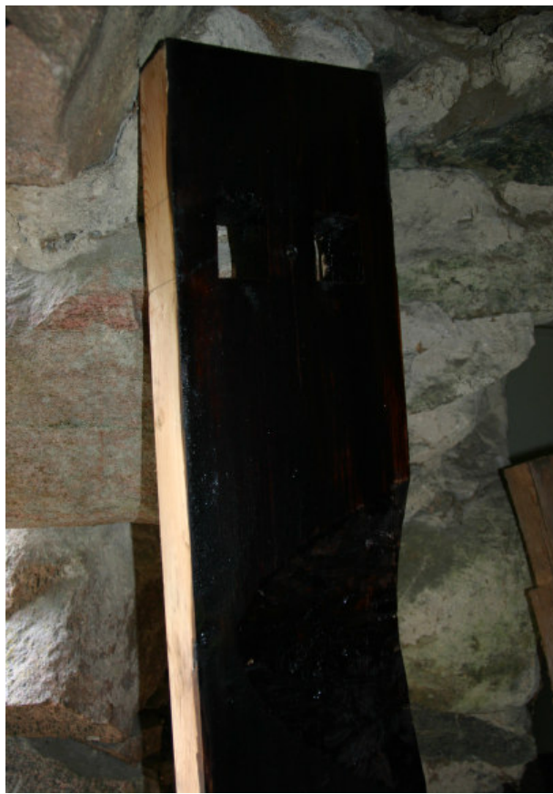
Tre karmstycken har tagits fram till den högra dörren i den södra fasaden. Sidostyckena tappas i det befintliga överstycket, se nästa sida, och till det nytillverkade understycket, se ovan till höger. Ytan som kommer att ligga mot murlivet har tjärats.
