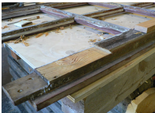
En del av ett sidostycke där nytt trä ska skarvas i, halvsulning. Nedan: Halvsulningen har limmat fast med kaseinlim och kommer bearbetas till rätt form. De fyra småbilderna - Foto Erik Bergholtz.
