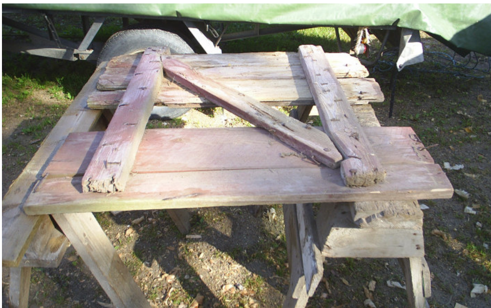
Den skadade luckan som suttit i den östra gaveln. Foto Fred Lagermar.
