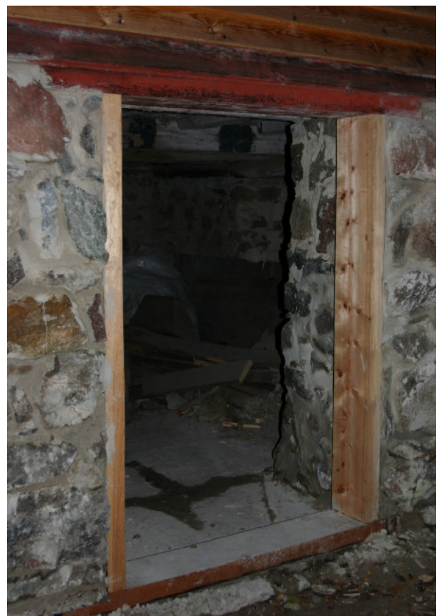
Det färdiga resultat men kar och uppmurad vägg. Murarbete har pågått samtidigt som träarbete. (Se rapport: Forsvisk industriminnen 2010:14.)
