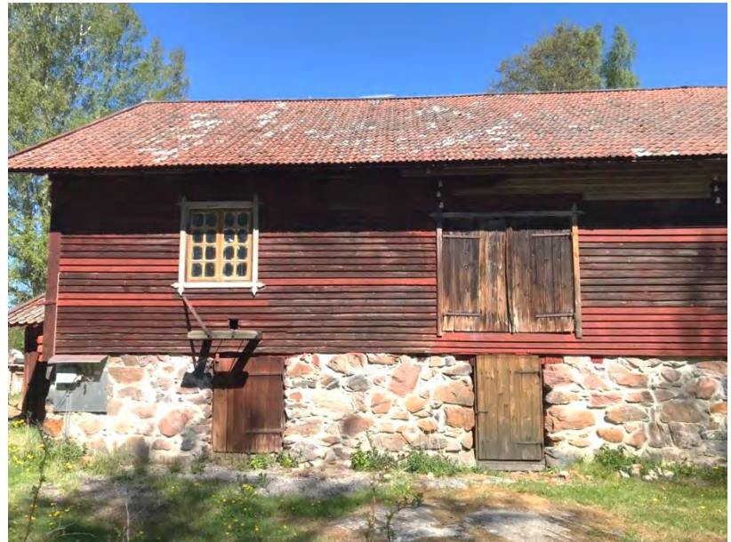
Fotografi över den södra fasadens fönster, dörrar och port. (17/5 - 22)
