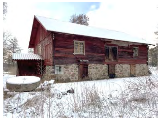
c. Fasad mot söder (11/1–2022)
