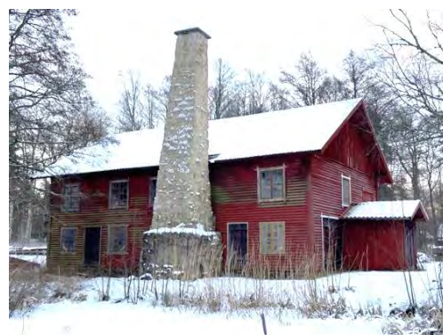
e. Fasad mot norr (11/1–2022)
