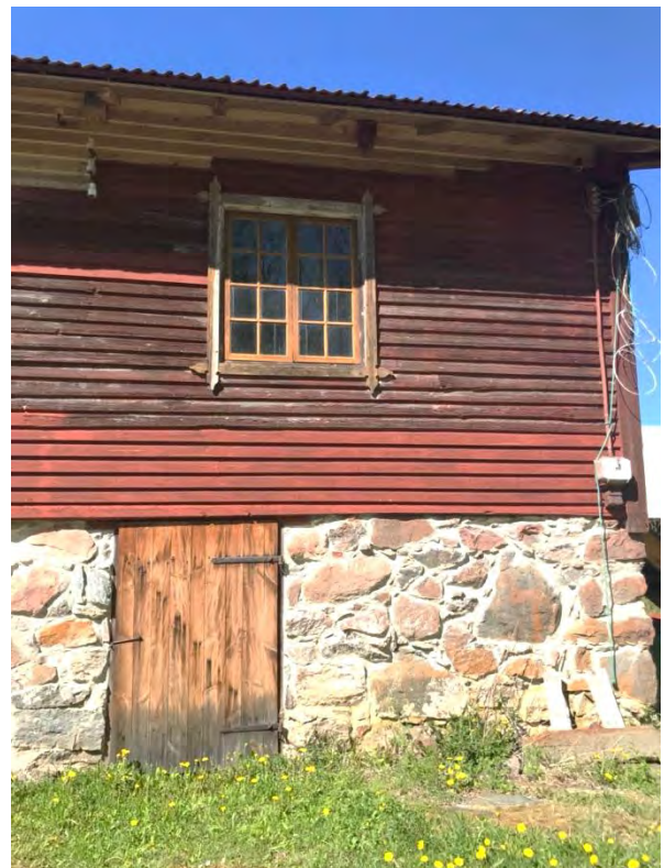
Fortsättning av den södra fasadens fönster och dörr. (17/5 - 22)
