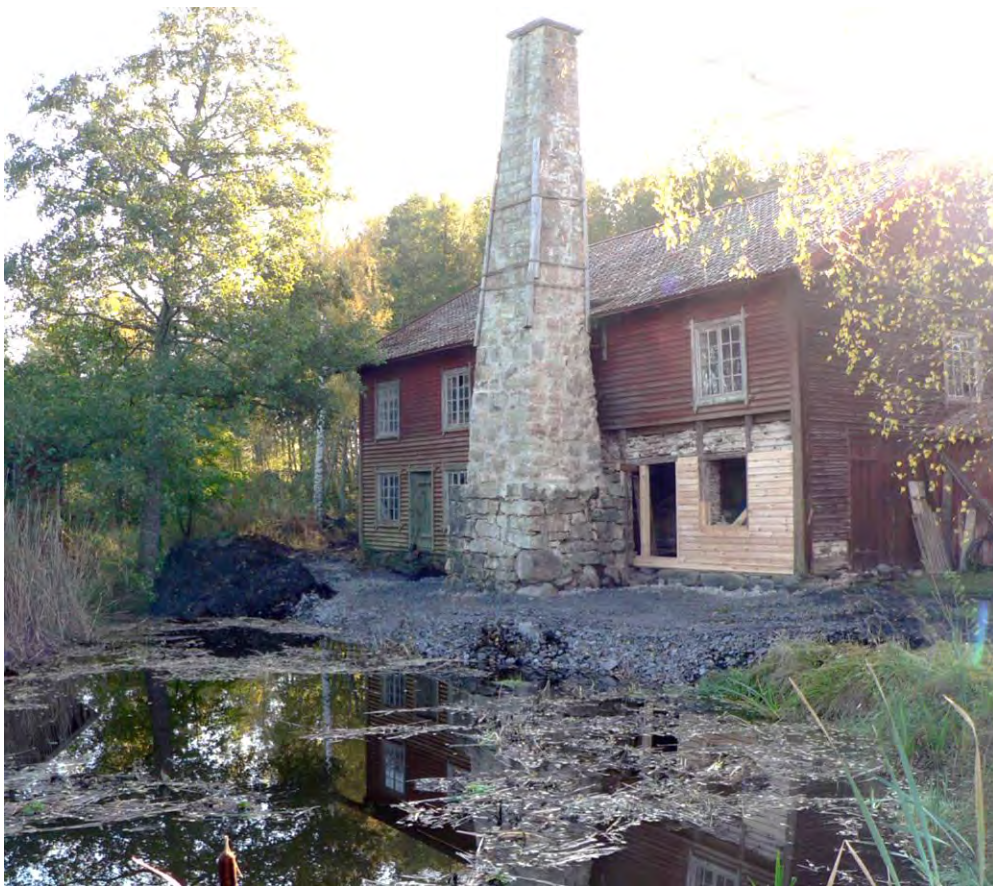
Tidigare åtgärder, på bilden har skorstenen säkrats upp 2010.
